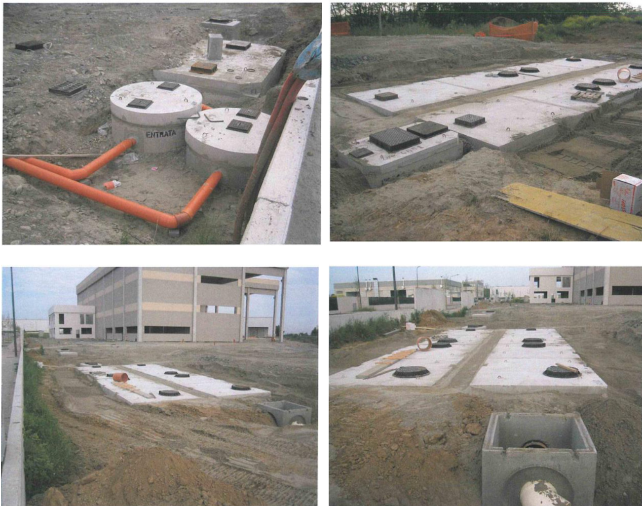
Figura 3-6 – Documentazione fotografica della posa del sistema di trattamento delle acque meteoriche (tratta da “Relazione tecnica relativa all'impianto trattamento acque prima pioggia della ditta Fidenza 2000/Valparma Rottami Srl” ad opera dell'Ing. Gian Franco Uni).
