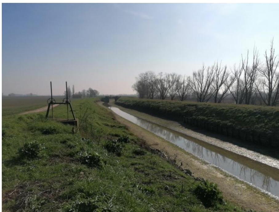
Foto 3.1. Canale Allacciante nel punto di prelievo con l'opera di presa posizionata sull'argine in sinistra nella foto (Foto Bioprogramm, febbraio 2024)
