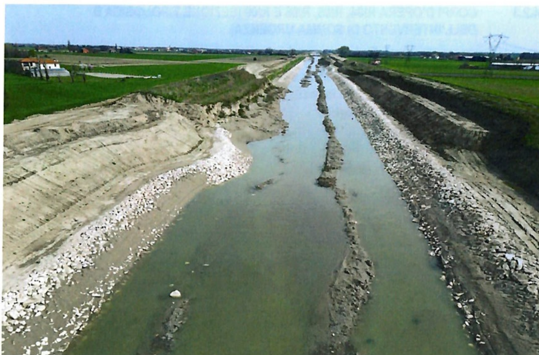
Figura 4-9: Lavori di ripristino delle arginature del T. Idice visti da monte verso valle. Sulla sinistra si notano le arginature ormai ricostruite di RI10 e RI06 (sez tipologica A) e il tratto RI08 (sezione tipologica D). Sulla destra, il corpo d'opera RI07 (Sezione tipologica B e C).
