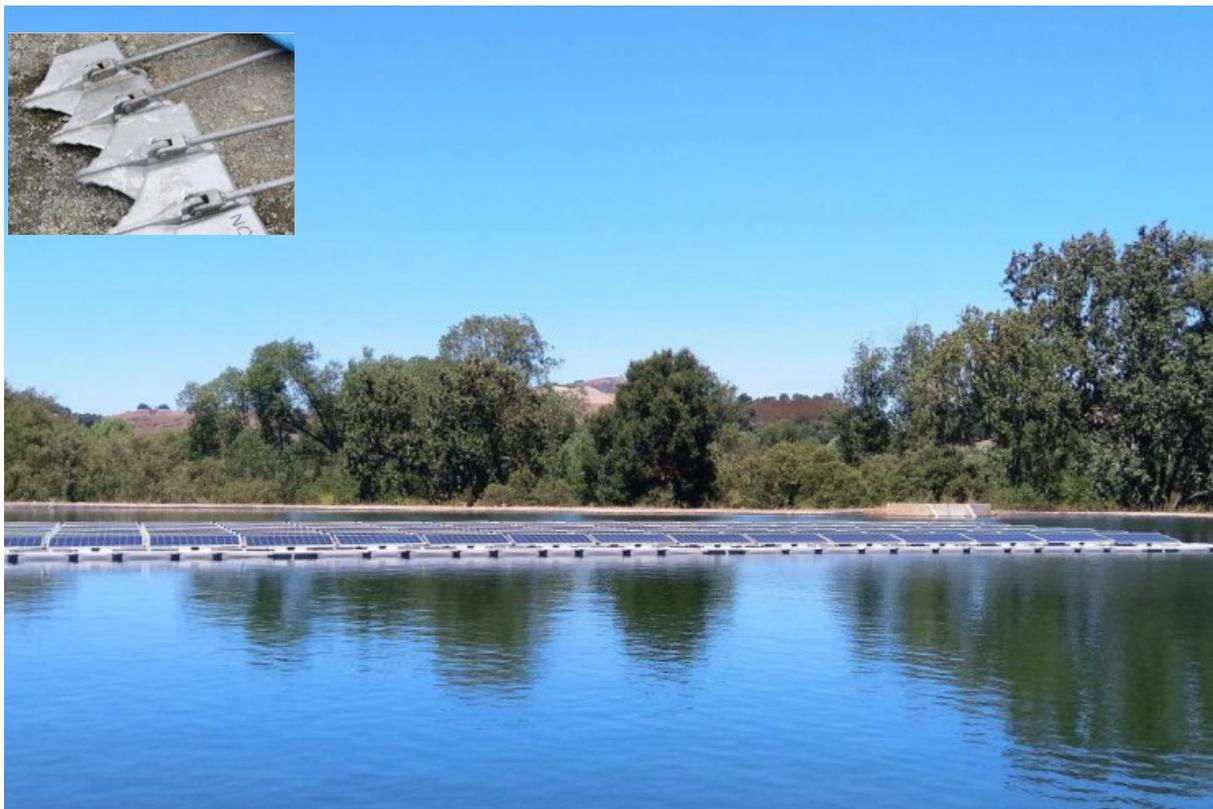
**Figura 7: Installazione su vasca di trattamento in California USA realizzata nel 2020 da Laketricity del gruppo Ciel&Terre (53 kWp, ancoraggio a percussione, copertura del 6%, profondità massima 4,8 m, variazione del livello dell'acqua 4,8 m)**
