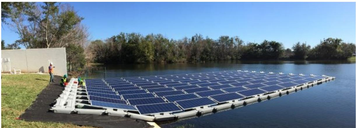
Figura 15: Tipologie di varo su rampa in legno o su tappeti, anche gonfiabili
