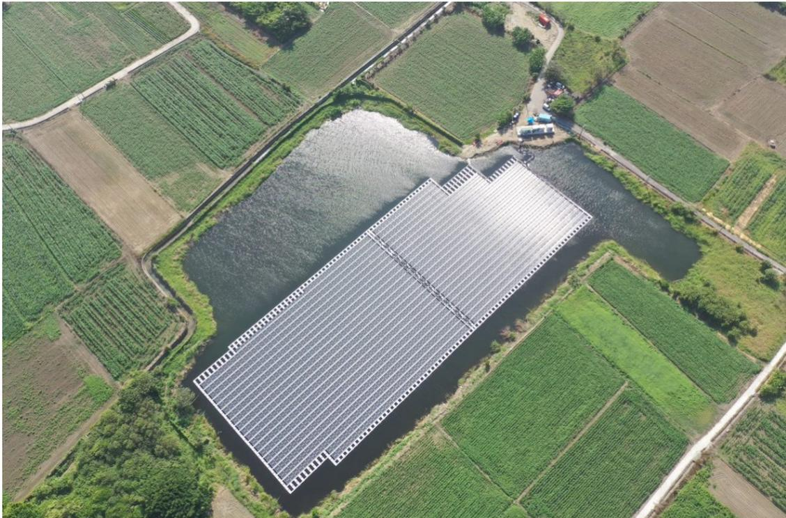
**Figura 9: Installazione su bacino naturale a Tainan in Taiwan realizzata nel 2020 da Laketricity del gruppo Ciel&Terre (1.251 kWp, ancoraggio sulle sponde, copertura del 66%, profondità massima 6 m, variazione del livello dell'acqua 2,5 m)**
