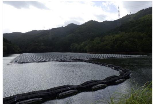
Figura 28: Esempio di cavi flottanti nel tratto che collega l'isola con la terraferma
