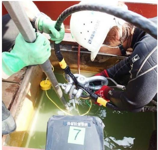
Figura 36: Esempio di installazione ancoraggio sul fondo del bacino
