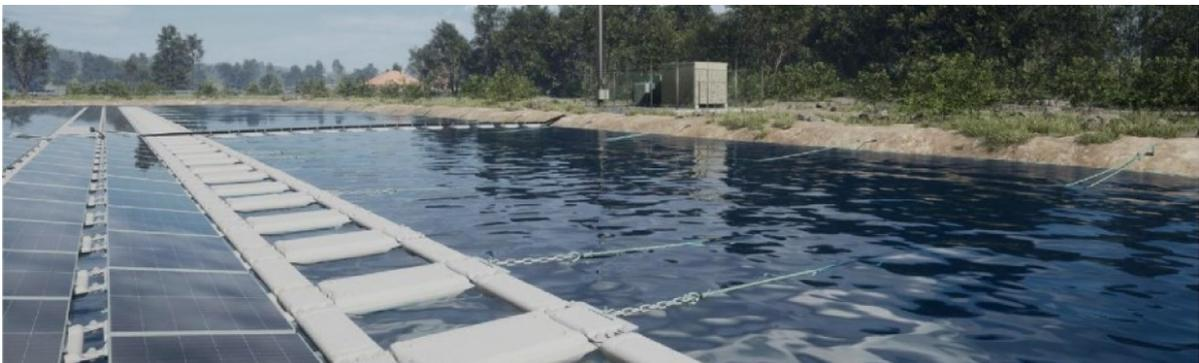
Figura 34: Esempi degli elementi di ancoraggio
