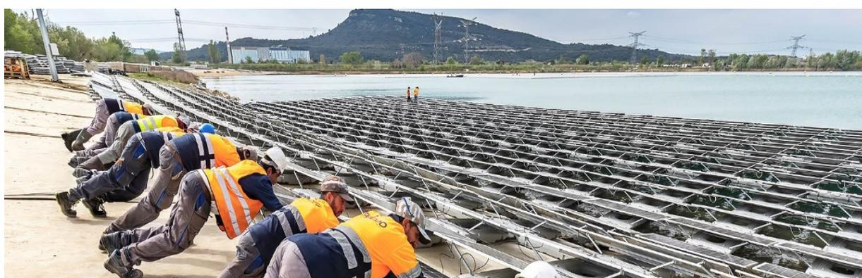
**Figura 18: Esempio di "spinta" delle stringhe fotovoltaiche in acqua**
