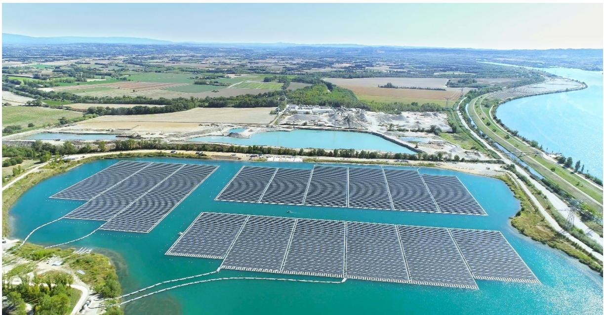
**Figura 10: Installazione su bacino di cava a Piolenc in Francia limitrofo ad un sito Natura 2000 nel 2019 da Laketricity del gruppo Ciel&Terre (17.015 kWp, ancoraggio con corpi morti sul fondo, copertura del 39%, profondità massima 12 m, variazione del livello dell'acqua 4 m)**
