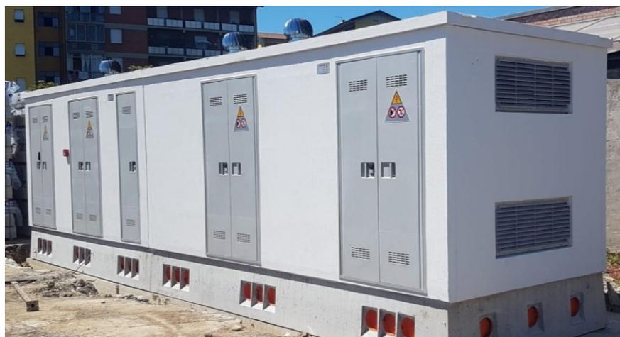
Figura 33: Esempio tipologica cabina elettrica prefabbricata (dimensioni indicative 11,6 x 2,48 m, altezza 2,6 m)
