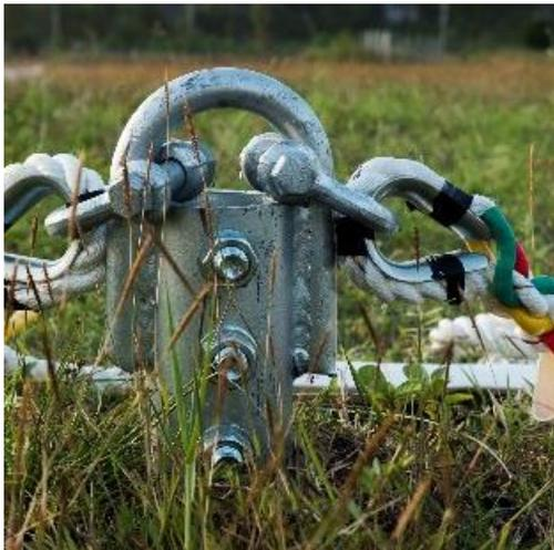
Figura 37: Esempio di installazione ancoraggio su banchina
