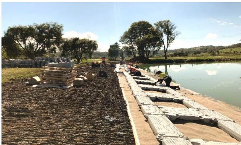
**Figura 16: Esempio di assemblaggio e scorrimento delle strutture galleggianti con sopra installato il modulo fotovoltaico**
