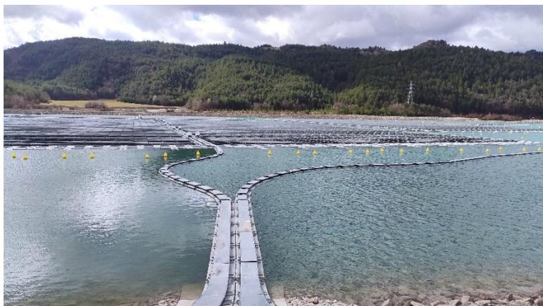
Figura 27: Esempio di cavi flottanti nel tratto che collega l'isola con la terraferma
