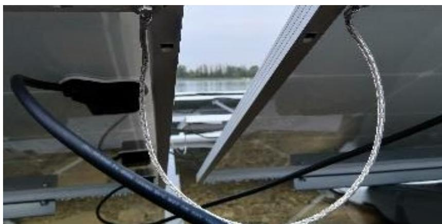
**Figura 17: Collegamento in serie dei moduli fotovoltaici (c.d. stringhe)**
