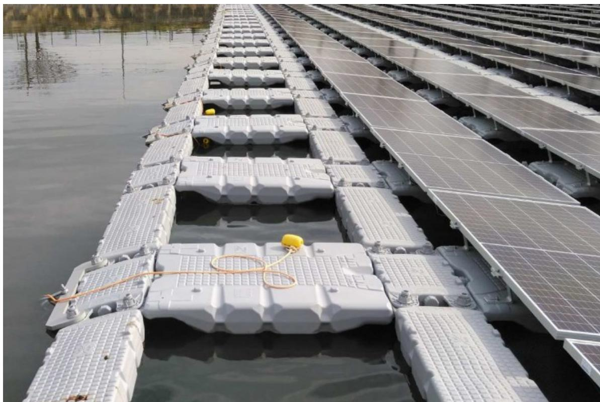
**Figura 8: Installazione su bacino di irrigazione nella prefettura di Nara in Giappone realizzata nel 2021 da Laketricity del gruppo Ciel&Terre (2.204 kWp, ancoraggio a percussione, copertura del 67%, profondità massima 5 m, variazione del livello dell'acqua 2 m)**
