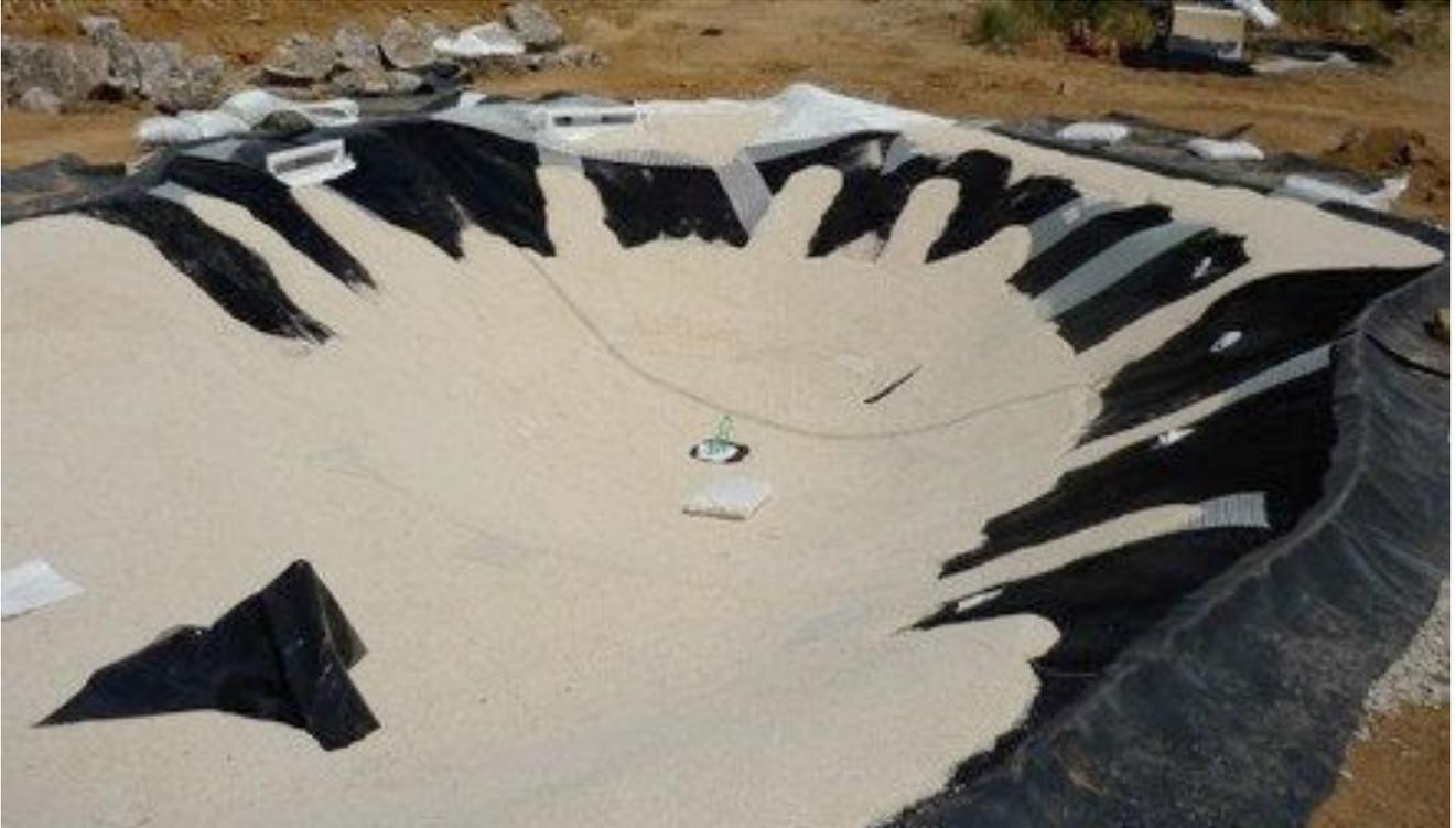
Sopra al telo in EPDM si procede poi a posizionare gli impianti di ricircolo dell'acqua, le reti strutturali e gli strati di pietra resinata di consolidamento della struttura.
