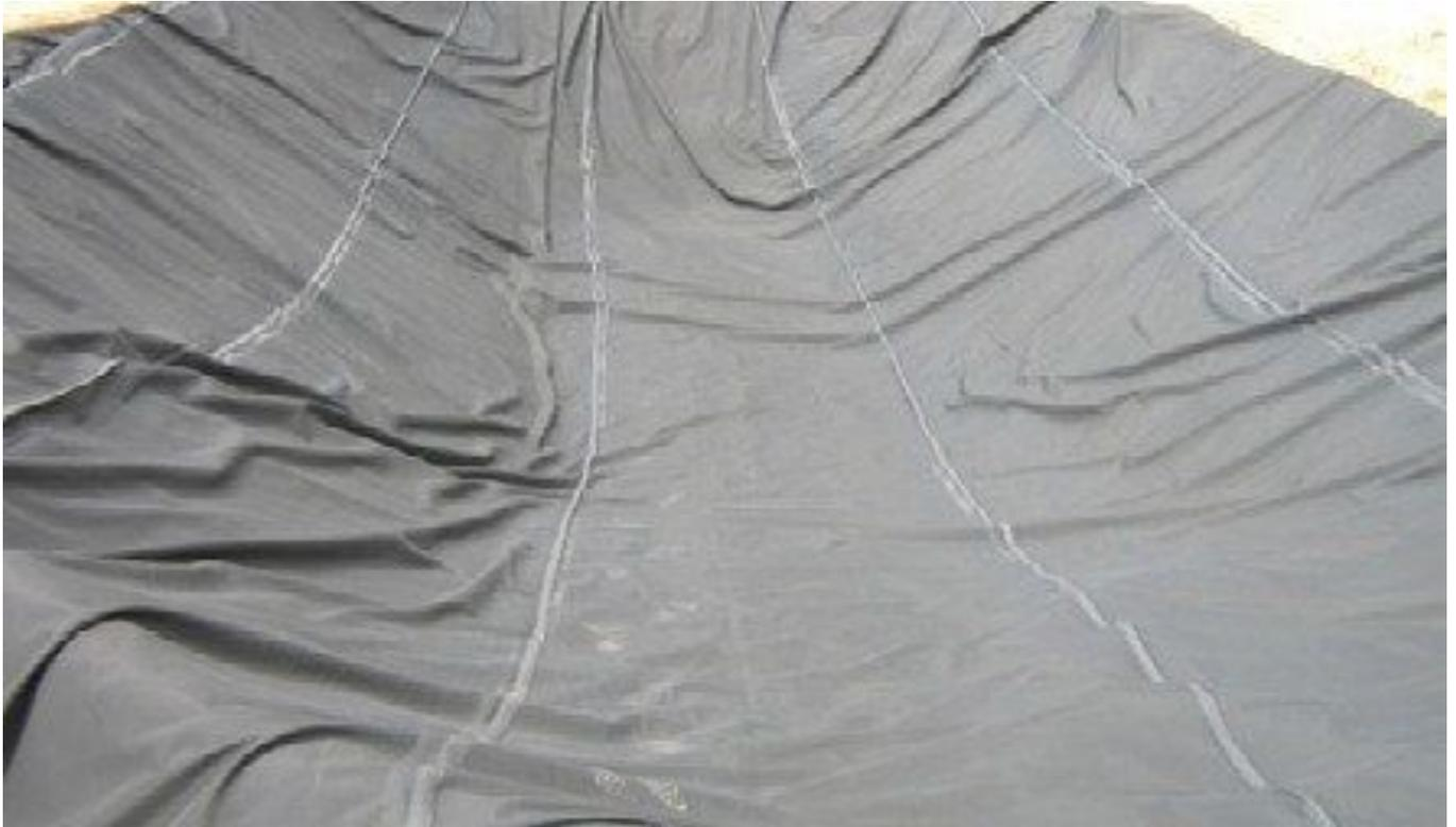
Sopra al tessuto geotessile viene steso un telo impermeabilizzante in EPDM, la cui elevata elasticità permette di assecondare qualsiasi movimento del terreno senza subire danneggiamenti e senza che si producano perdite d'acqua. In questa fase vengono inoltre flangiate tutte le bocchette e gli skimmer dell'impianto di ricircolo.
