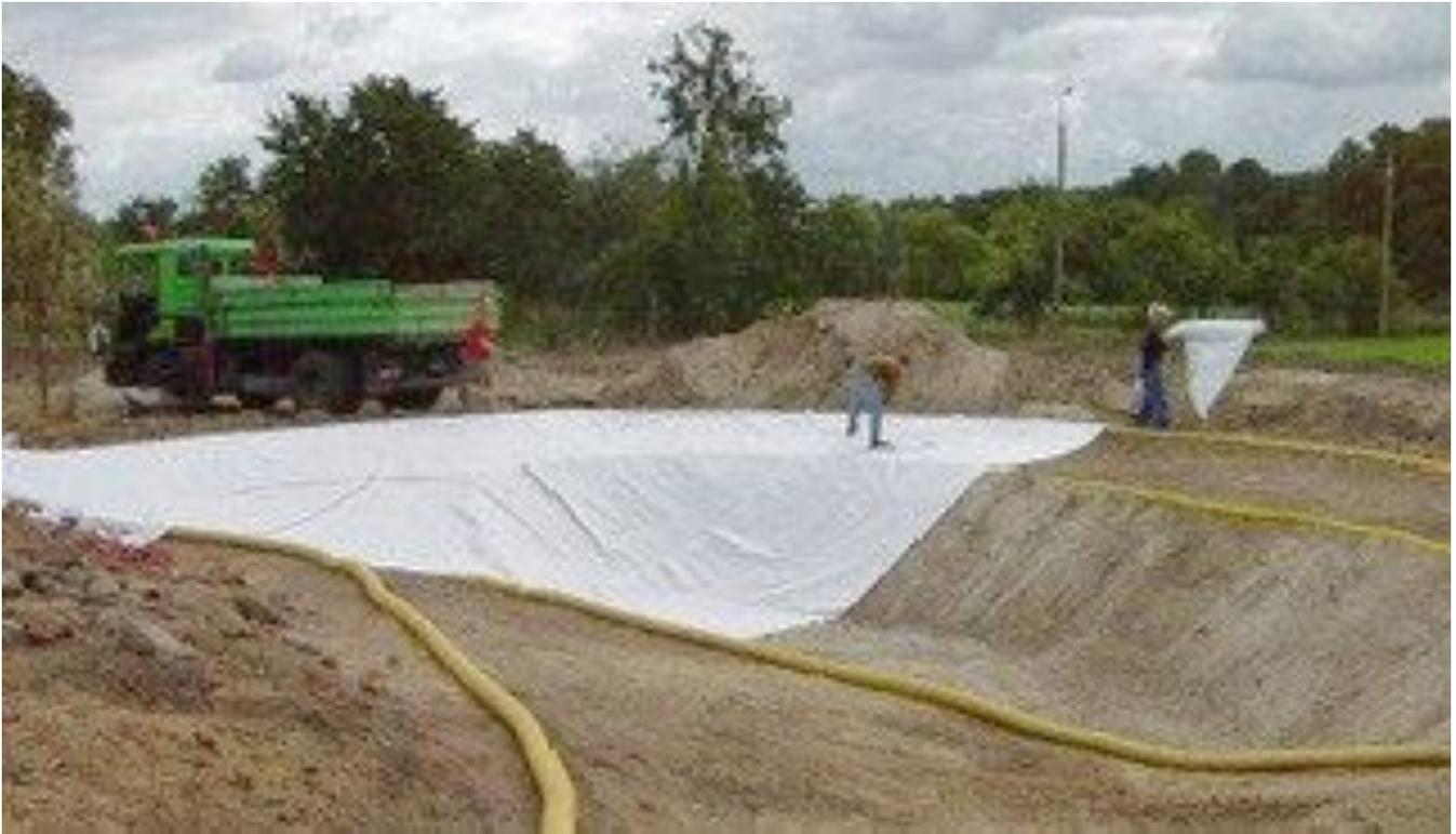
Dopo il posizionamento di tutte le bocchette necessarie per un corretto funzionamento degli impianti, viene steso sullo scavo un telo protettivo in materiale geotessile, allo scopo di proteggere il telo impermeabilizzante in EPDM da eventuali danneggiamenti dovuti a pietre appuntite o radici.
