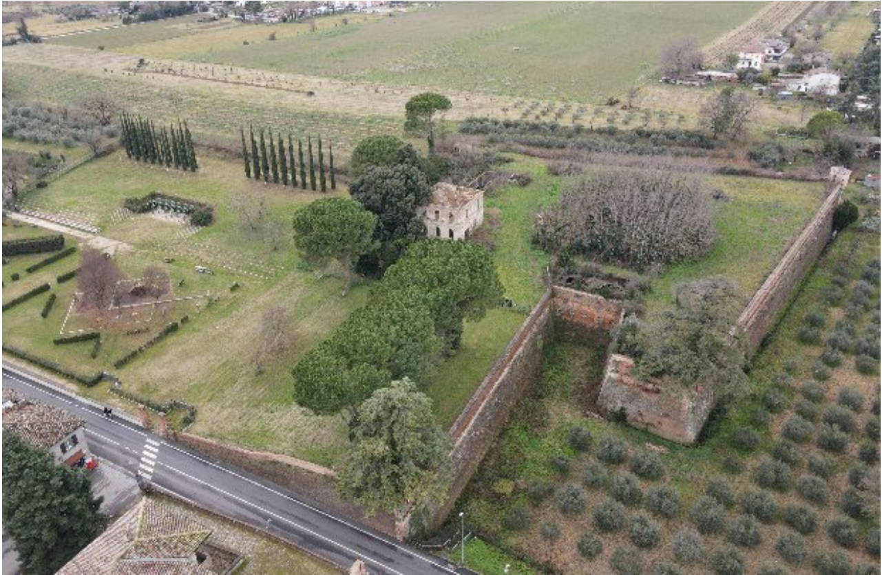
Figura 1 – Vista aerea del Bastione di Santa Maria: l'accesso ai due livelli sotterranei delle Casematte è situato a ridosso della villa ottocentesca diruta. L'intervento comprenderà sia il sistema di gallerie seminterrate ed interrate, sia l'area scoperta sommitale attualmente chiusa al pubblico.
