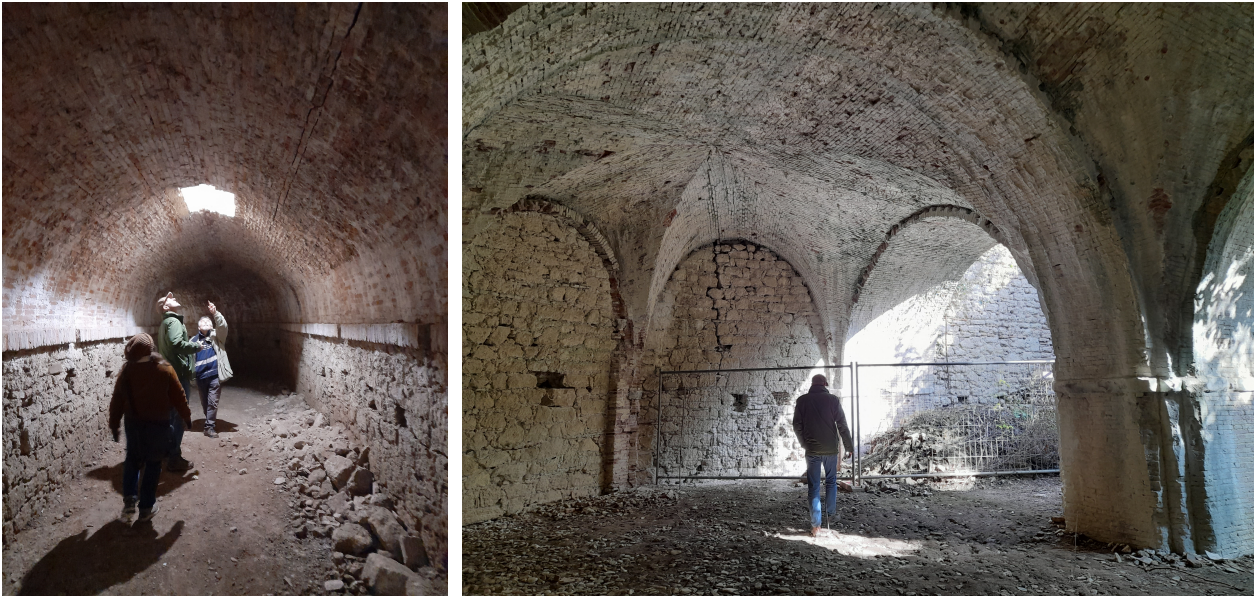
Figura 2-3 – Alcune immagini dei grandiosi ambienti seminterrati e delle gallerie interrate che compongono il sistema su due livelli delle Casematte del Bastione di Santa Maria.
