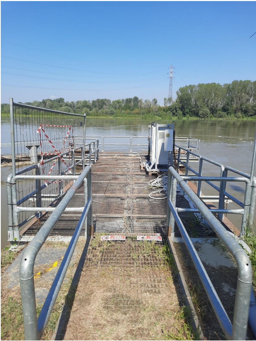
Foto 11 – Vista dal pontile
