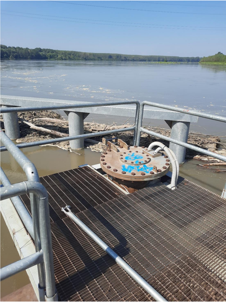
Foto 10 – Vista dal pontile
