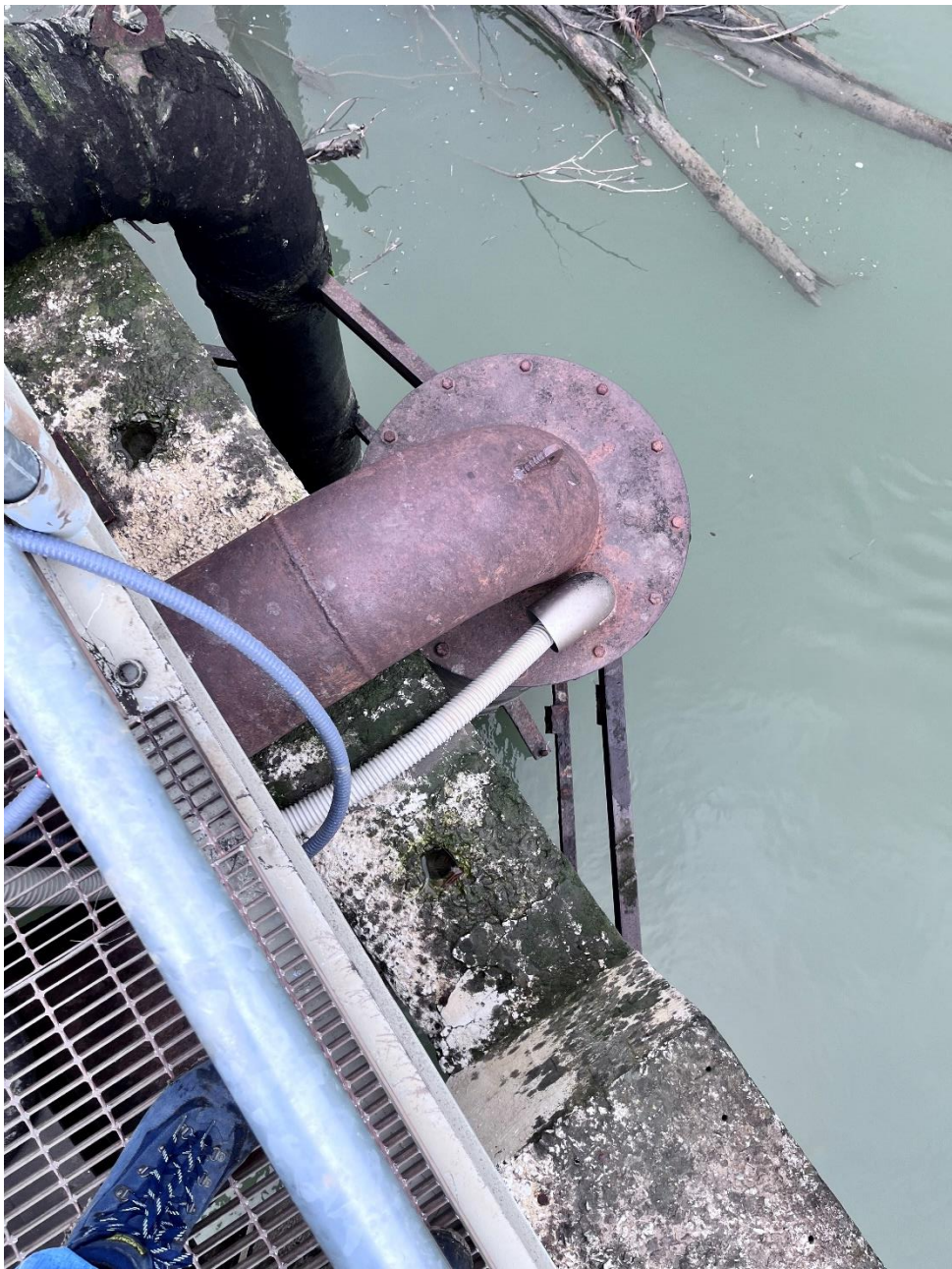
Foto 5 – Vista dal pontile
