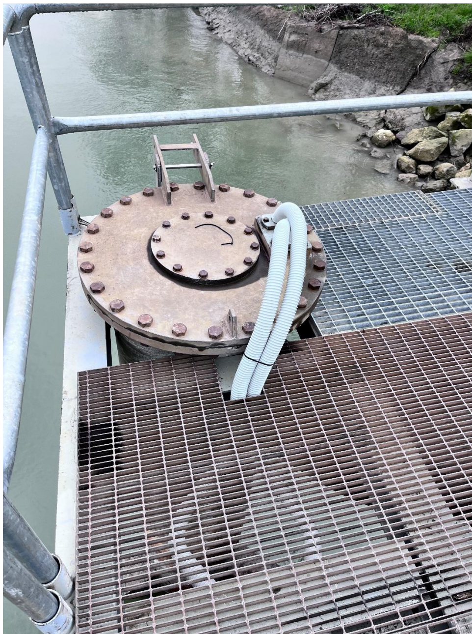
Foto 6 – Vista dal pontile
