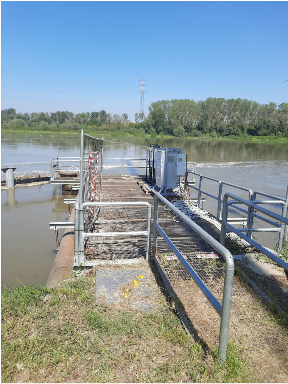
Foto 8 – Vista dal pontile della palificazione di protezione del pontile
