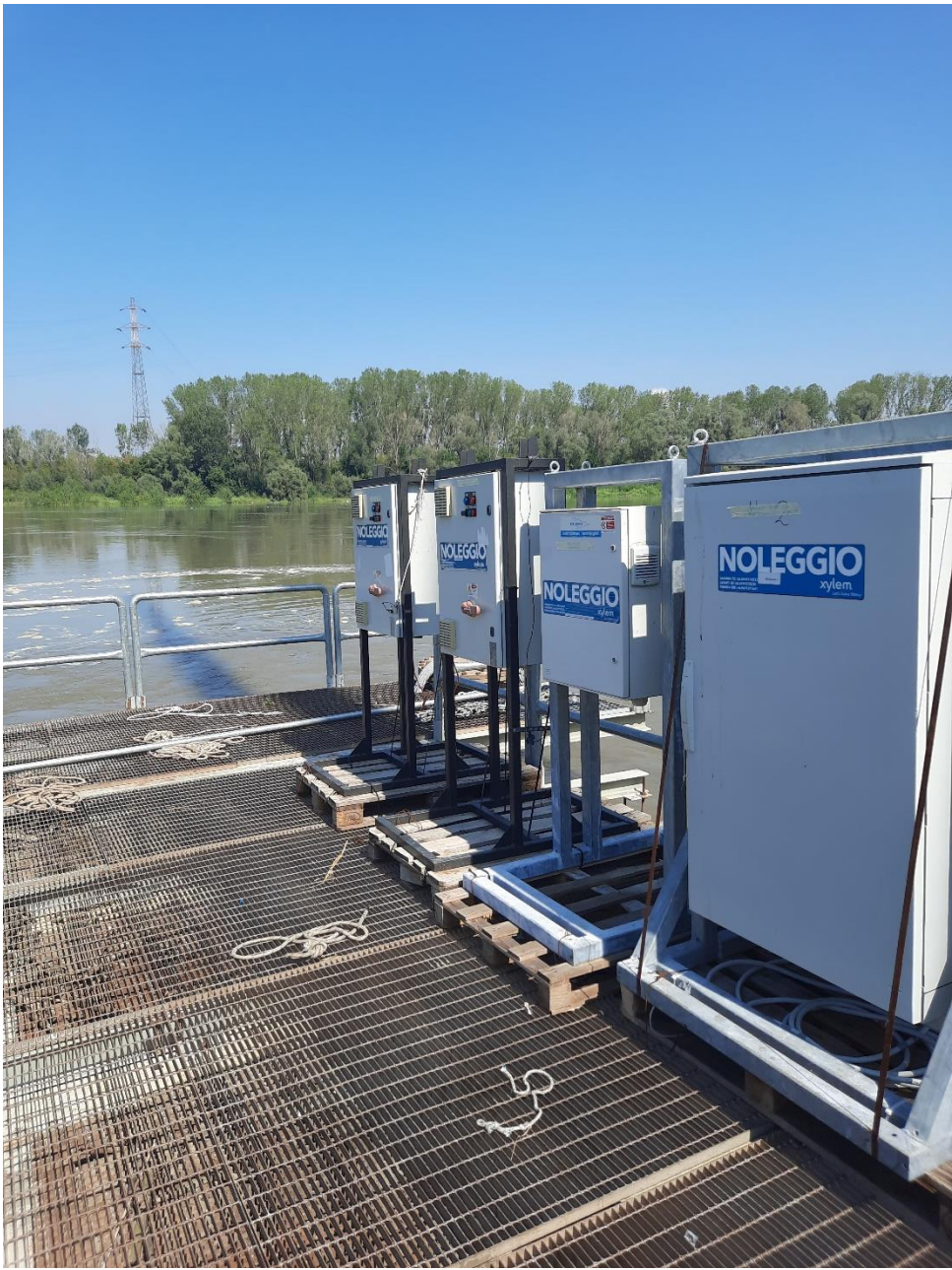
Foto 9 – Vista dal pontile
