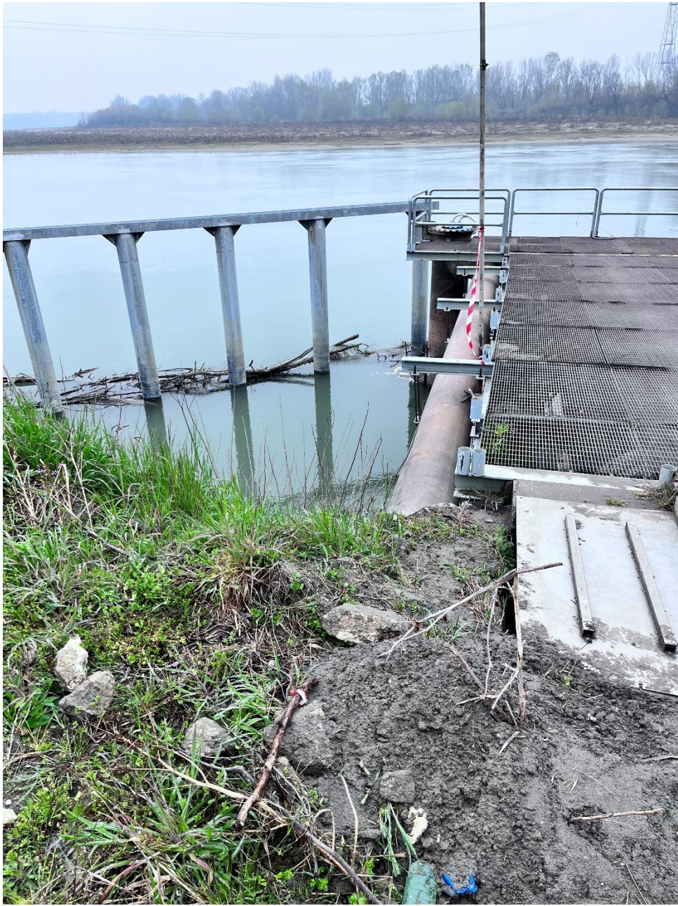
Foto 7 – Vista dal pontile della palificazione di protezione del pontile
