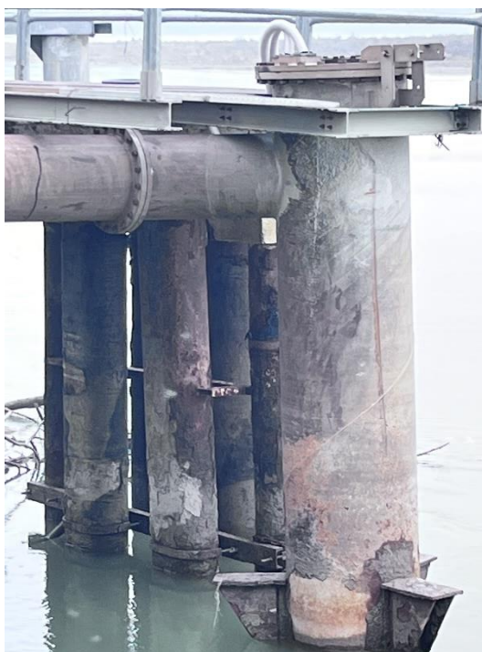
figura 4 – Sistema di captazione Pontile
