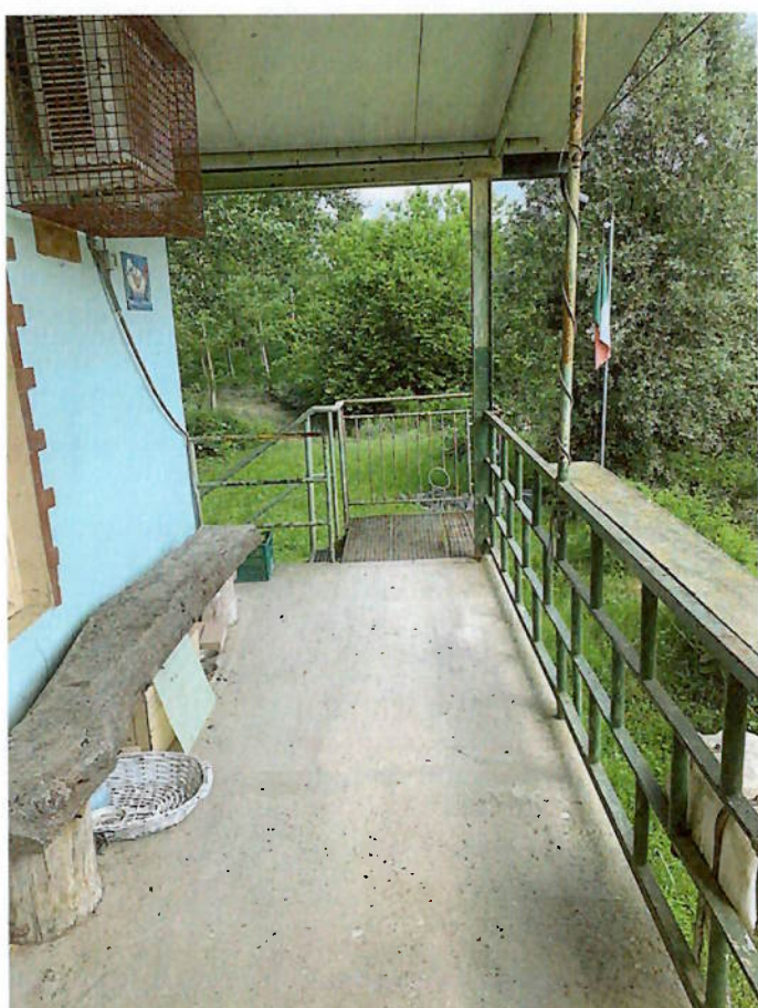
BALCONATA LATO EST VISTA DA SUD
