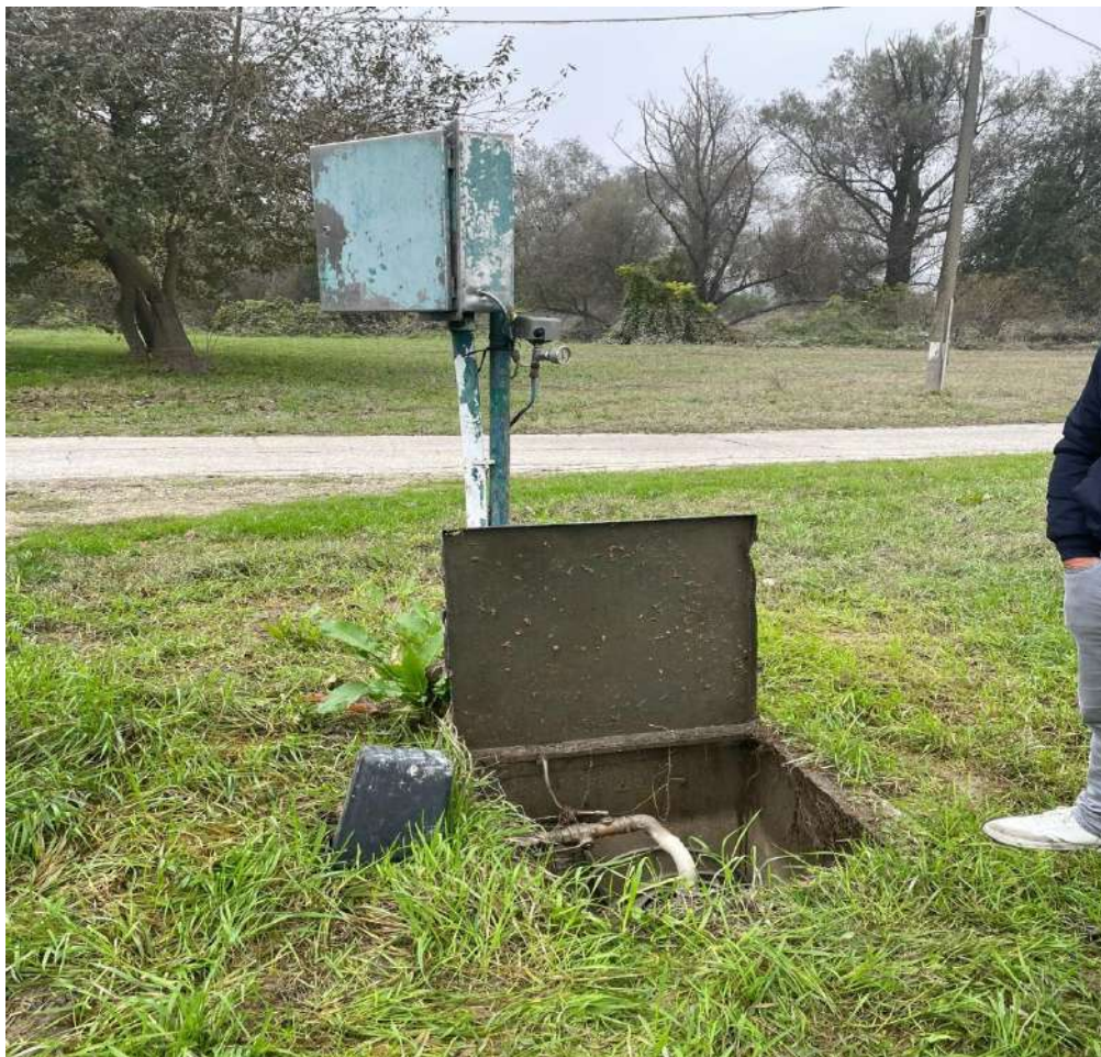
Figura 1: Foto frontale del pozzetto.
