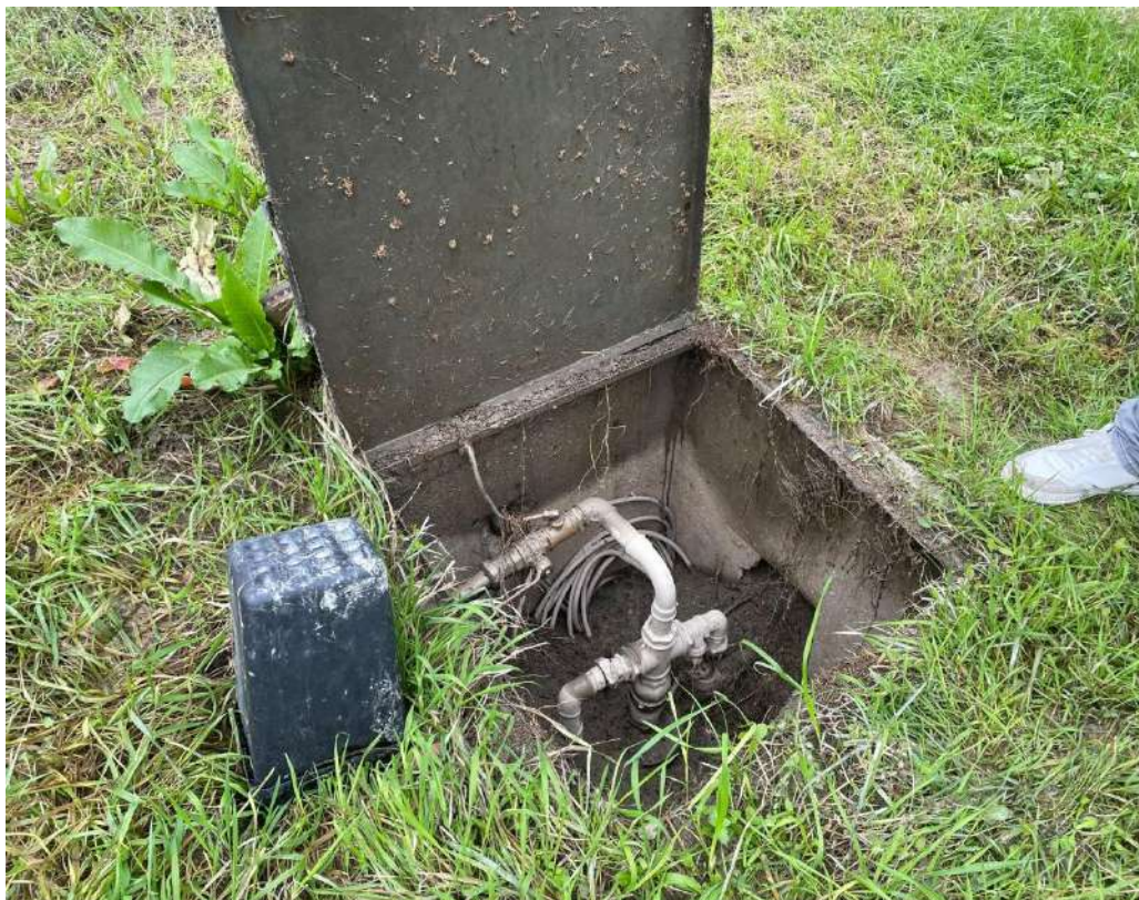
Figura 2: Particolare del pozzetto.
