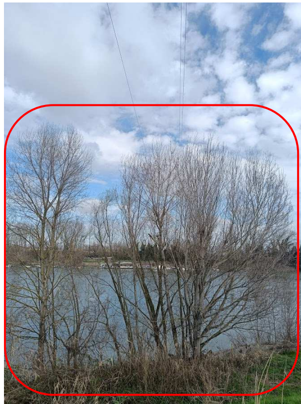
Foto 4: vista sud-nord della sponda in comune di Ferrara ove vegetano gli otto giovani esemplari arborei oggetto di taglio per manutenzione ordinaria della linea elettrica (sopra le chiome si notano i cavi aerei)
