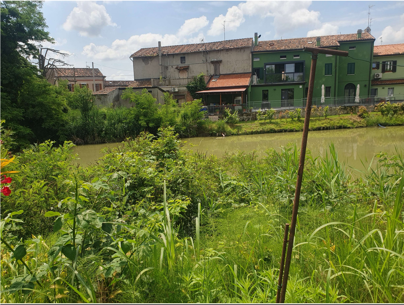
Foto dettaglio area sponda canale interessata all'intervento
