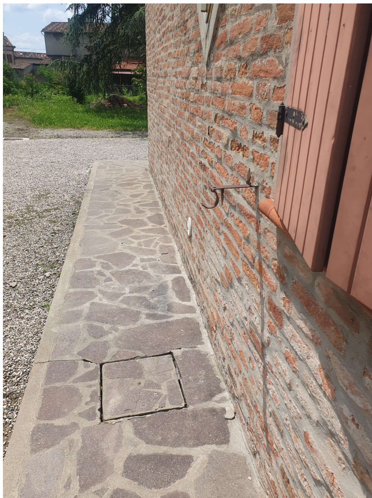
Foto dettaglio prospetto Est Abitazione – direzione scarico verso canale
