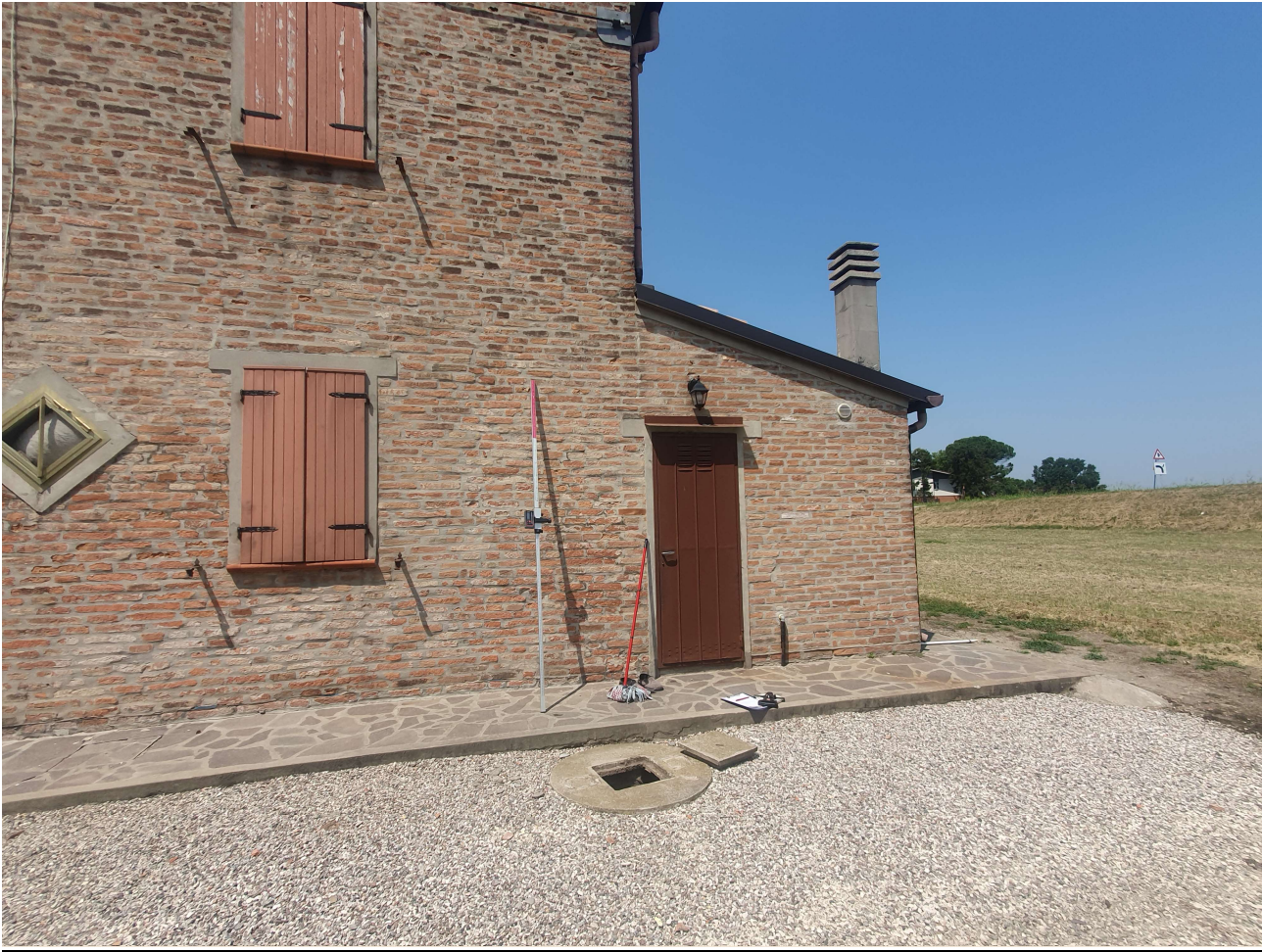
Foto dettaglio vasca biologica prospetto Est Abitazione
