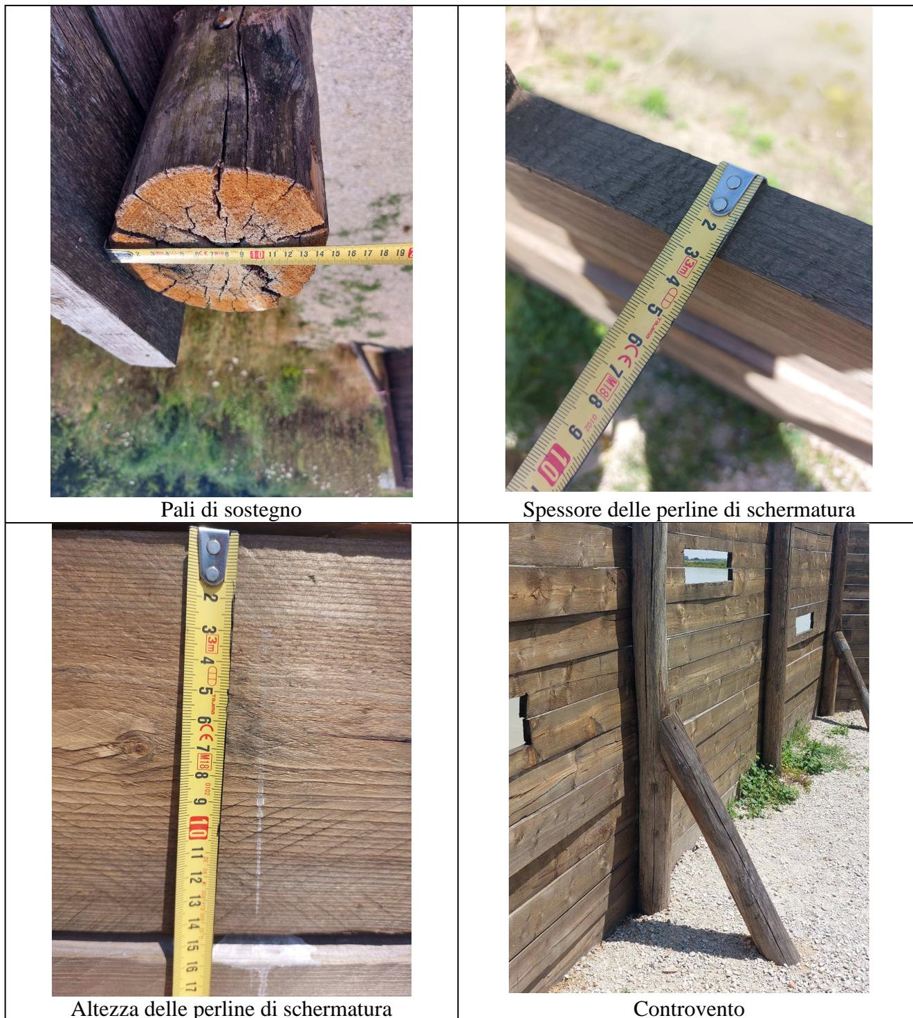
Fig.3. Dettagli degli elementi che compongono la struttura
