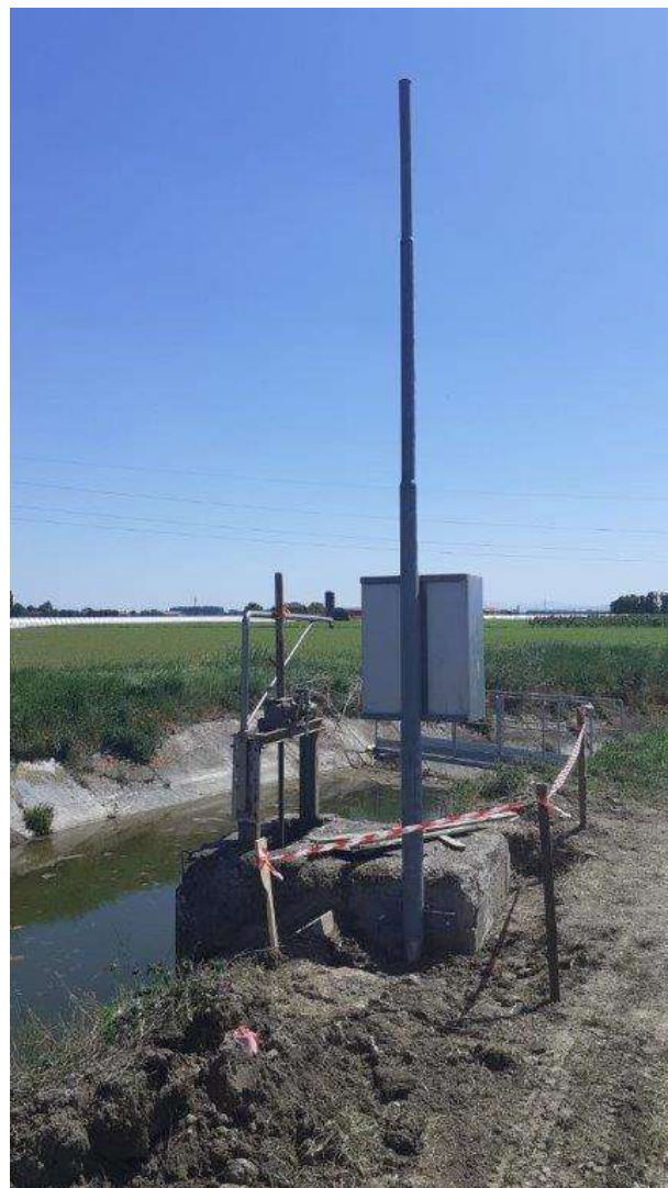
Fase di lavoro durante l'installazione della centralina
