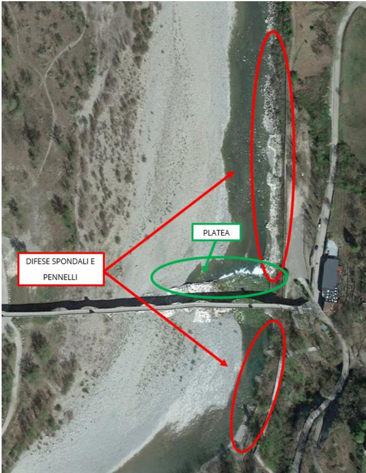
COR. 6 Aree d'intervento sul fiume Trebbia - Immagine satellitare anno 2022 - Indicazione delle opere idrauliche esistenti oggetto di manutenzione e ripristino funzionale - Intervento di cat. A.35 DPR 31/2017 : "... interventi di manutenzione e ripristino funzionale [...] delle opere idrauliche in alveo " (cfr. Relazione Generale, par. 4.5 -TUTELA AMBIENTALE - NORMATIVE/PIANIFICAZIONI COMUNITARIE, NAZIONALI, REGIONALI E PROVINCIALE) (database: Google Satellite)
