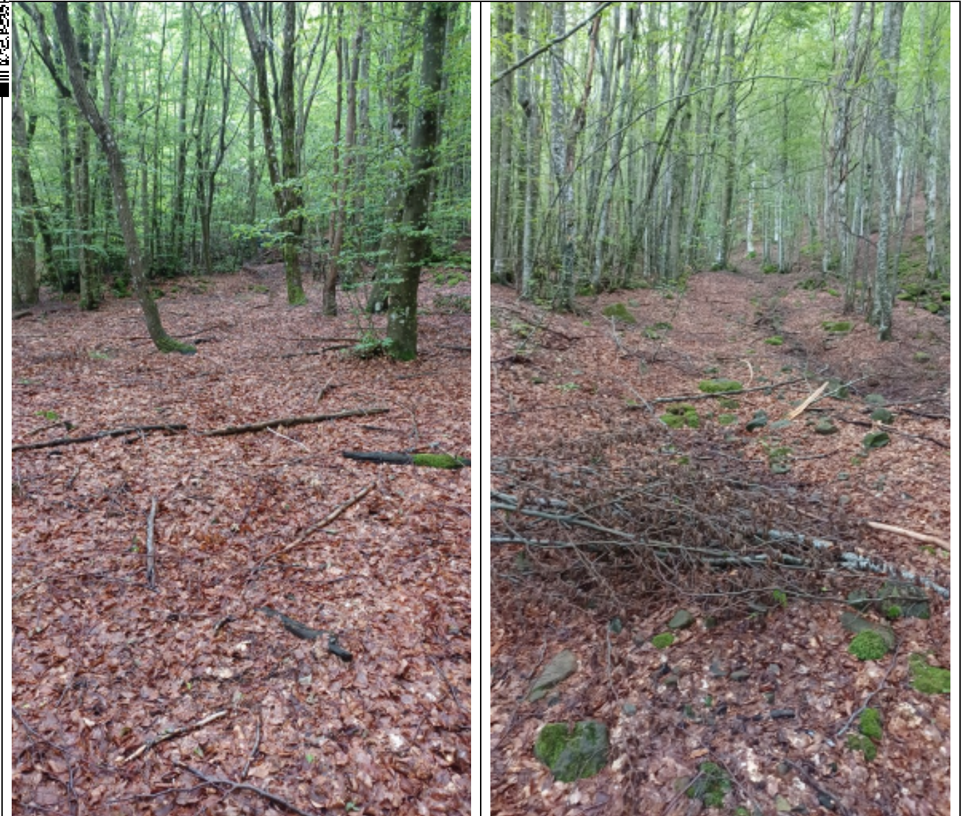
Ripristino con allargamento ex comunale e mulattiera esistente
