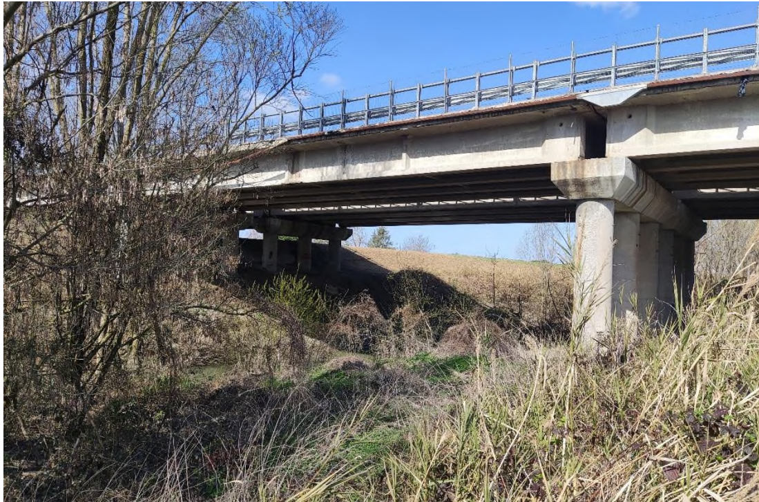
Figura 11-7. Vegetazione in alveo nei pressi delle pile 4 e 5
