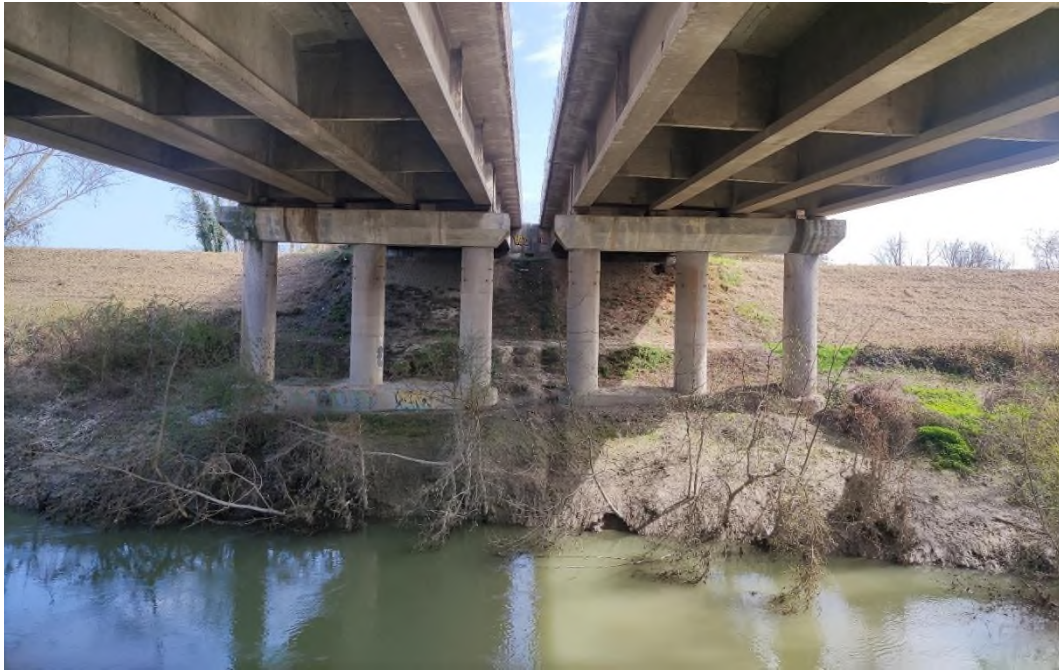
Figura 6-2. Condizioni dell'habitat 92A0 nei pressi della pila 5
