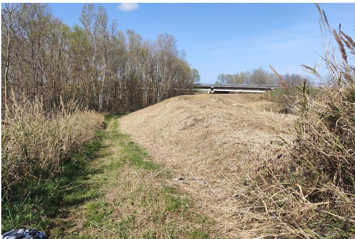
Figura 11-9. Pista di servizio per i lavori in alveo
