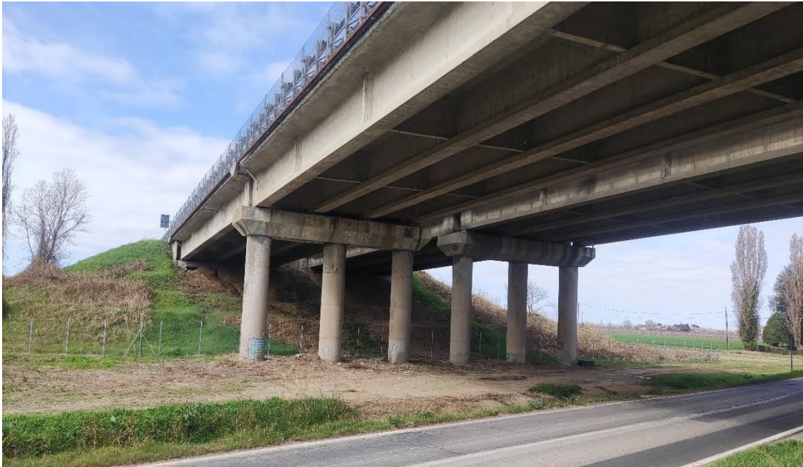
Figura 11-1. Pila 1 e spalla direzione Bologna
