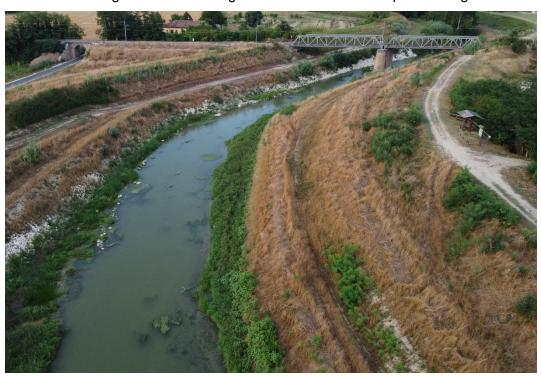
Il tratto arginato del corso del fiume Lamone, a monte della ferrovia Russi - Bagnacavallo, presenta una sezione idraulica non adeguata alle portate previste dal Piano di Assetto Idrogeologico, Progetto di Variante/Coordinamento tra Piano di Gestione del Rischio Alluvioni e Piano Stralcio per il Rischio Idrogeologico.
