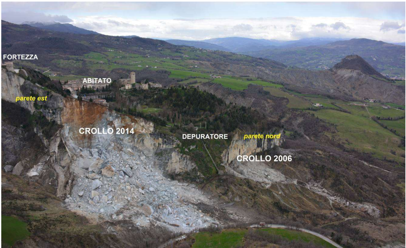
Fig. 2. Il grande crollo del 2014 che ha interessato lo spigolo nord-est della rupe di San Leo. Un ulteriore crollo ha interessato la parte nord nel 2006.
