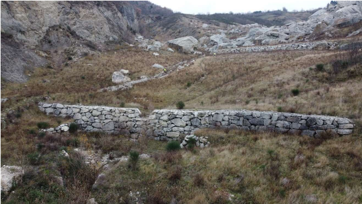
Fig. 4. Immagini ravvicinate delle due opere strutturali realizzate nel recente passato e ben integrate nel contesto ambientale e geomorfologico.
