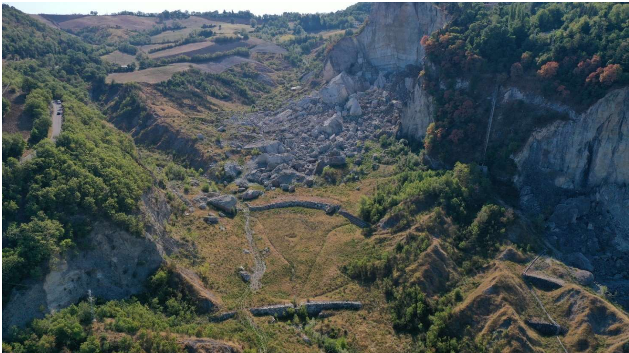
Fig. 3. Il fosso Campone visto da valle con le due opere di contenimento realizzate nel 2015 per la stabilizzazione del detrito del crollo 2014 e l'eliminazione del fenomeno di sgrottamento alla base della parte.
