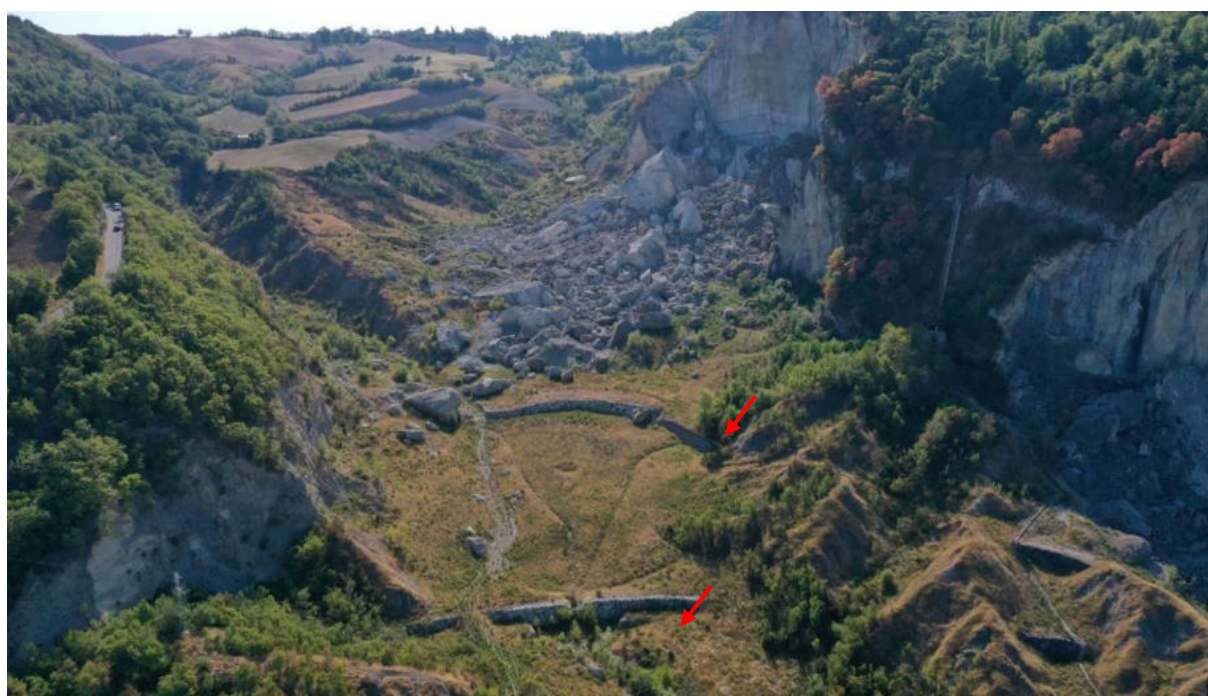
Fig. 7. Il fosso Campone visto da valle con le due opere di contenimento (frecce) realizzate nel periodo 2014-2016 per la stabilizzazione del detrito del crollo 2014.
