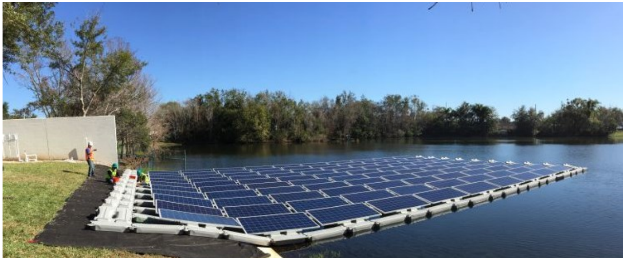
Figura 13: Tipologie di varo su rampa in legno o su tappeti, anche gonfiabili
