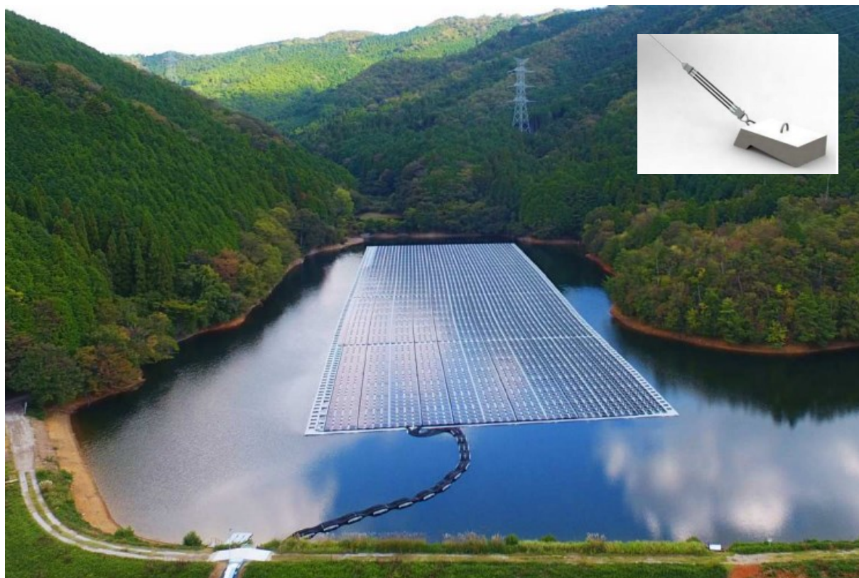
Figura 5: Installazione su bacino di irrigazione nella prefettura di Hyogo in Giappone realizzata nel 2020 da Laketricity del gruppo Ciel&Terre (1.860 kWp, ancoraggio con corpi morti sul fondo, copertura del 42%, profondità massima 10 m, variazione del livello dell'acqua 3 m)
