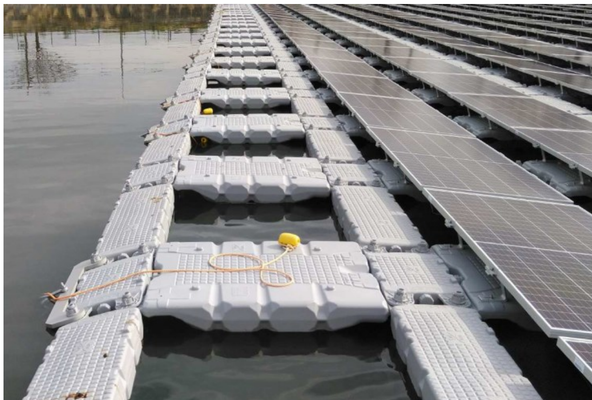
Figura 7: Installazione su bacino di irrigazione nella prefettura di Nara in Giappone realizzata nel 2021 da Laketricity del gruppo Ciel&Terre (2.204 kWp, ancoraggio a percussione, copertura del 67%, profondità massima 5 m, variazione del livello dell'acqua 2 m)
