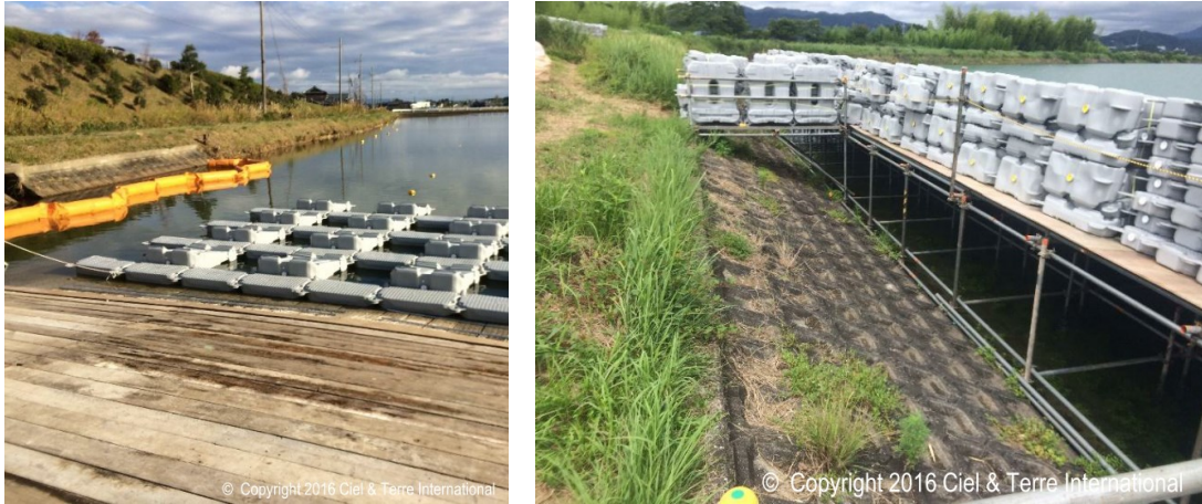
Figura 5: Esempio di varo utilizzando rampe in legno sollevate da terra
