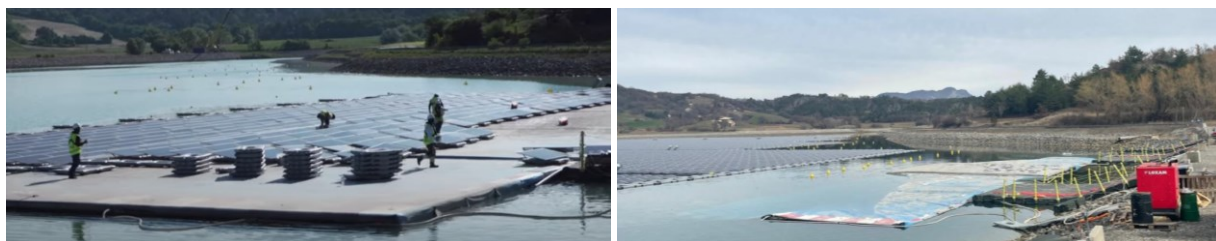
Figura 4: Esempio di varo utilizzando piattaforme galleggianti sgonfiabili (centrale solare flottante di Lazer a Hautes-Alpes 1 in Francia- EDF Renouvelables)
