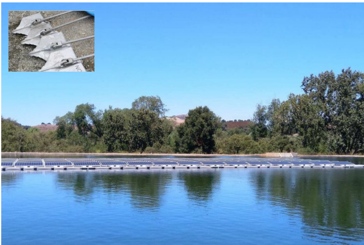
Figura 6: Installazione su vasca di trattamento in California USA realizzata nel 2020 da Laketricity del gruppo Ciel&Terre (53 kWp, ancoraggio a percussione, copertura del 6%, profondità massima 4,8 m, variazione del livello dell'acqua 4,8 m)
