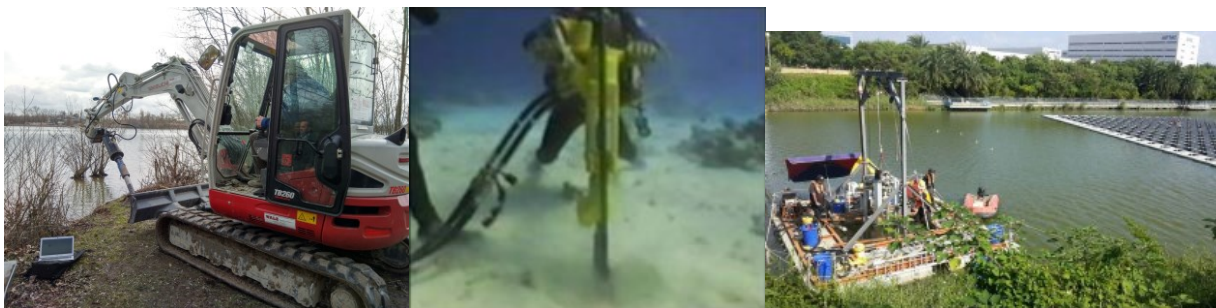
Figura 6: Esempio di attrezzature per l'infissione di ancoraggi
