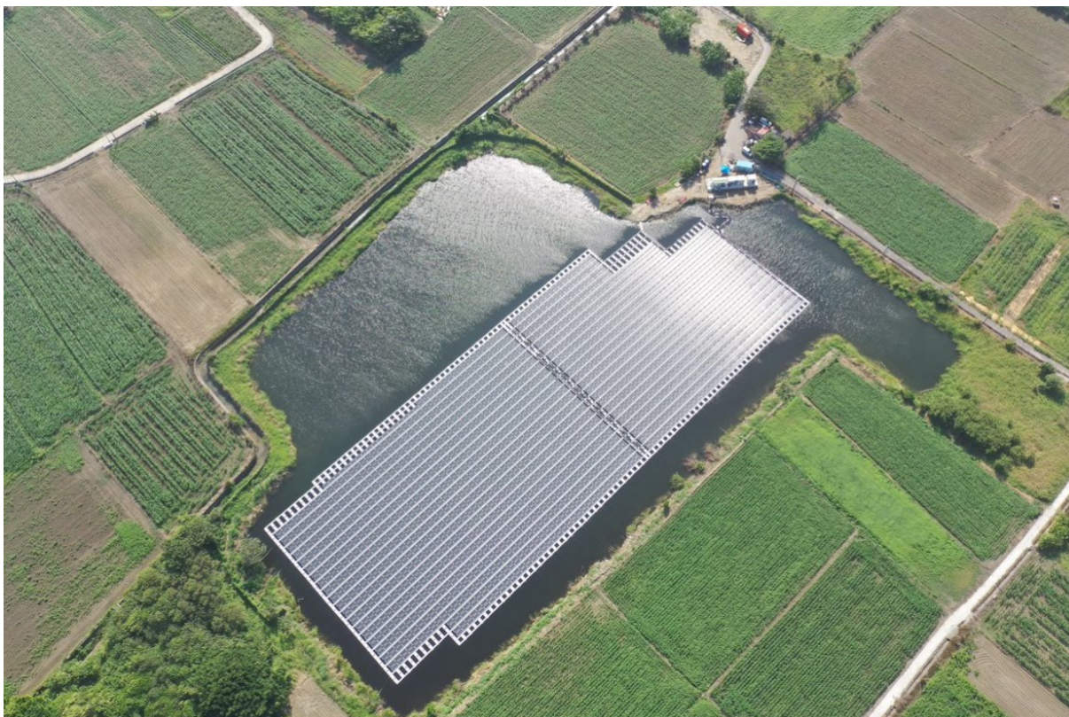
Figura 8: Installazione su bacino naturale a Tainan in Taiwan realizzata nel 2020 da Laketricity del gruppo Ciel&Terre (1.251 kWp, ancoraggio sulle sponde, copertura del 66%, profondità massima 6 m, variazione del livello dell'acqua 2,5 m)
