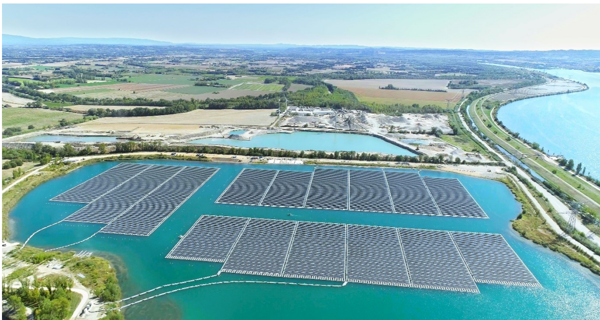
Figura 9: Installazione su bacino di cava a Piolenc in Francia all'interno di un sito Natura 2000 nel 2019 da Laketricity del gruppo Ciel&Terre (17.015 kWp, ancoraggio con corpi morti sul fondo, copertura del 39%, profondità massima 12 m, variazione del livello dell'acqua 4 m)
