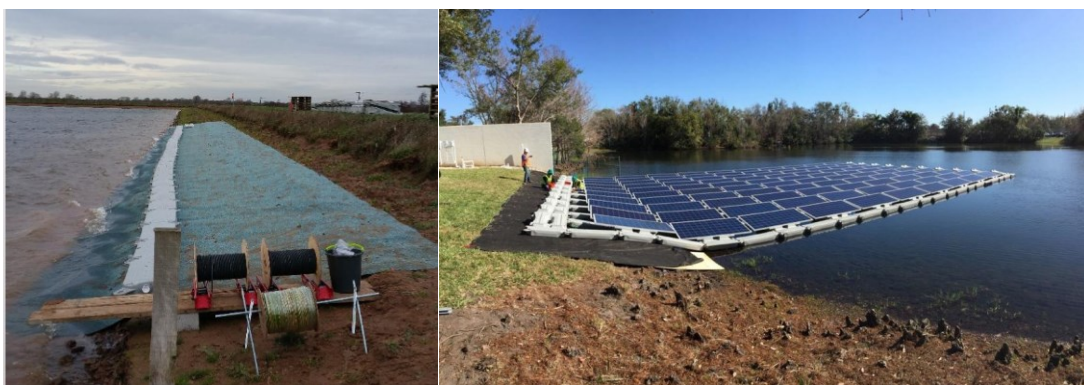
Figura 3: Esempio di varo utilizzando appositi teli
