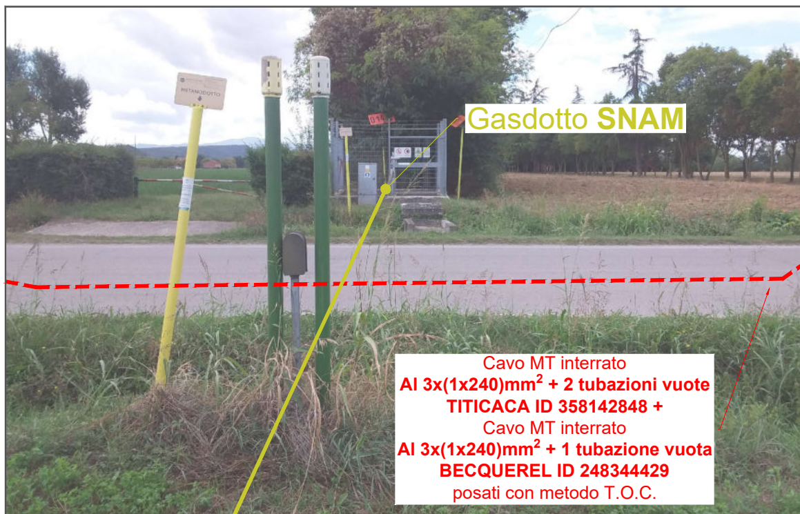
Foto 11: Nuova linea MT in partenza dalla cabina primaria CP COLLECCHIO in percorrenza lungo via Scodoncello ed in attraversamento a Gasdotto SNAM
