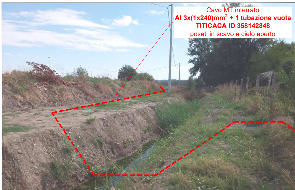
Foto 26: Nuova linea MT in partenza dalla cabina primaria CP COLLECCHIO in attraversamento di canale esistente.
