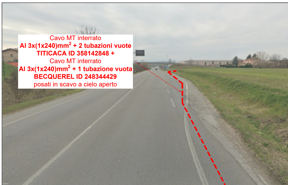
Foto 8: Nuova linea MT in partenza dalla cabina primaria CP COLLECCHIO in attraversamento della Strada Statale 62
