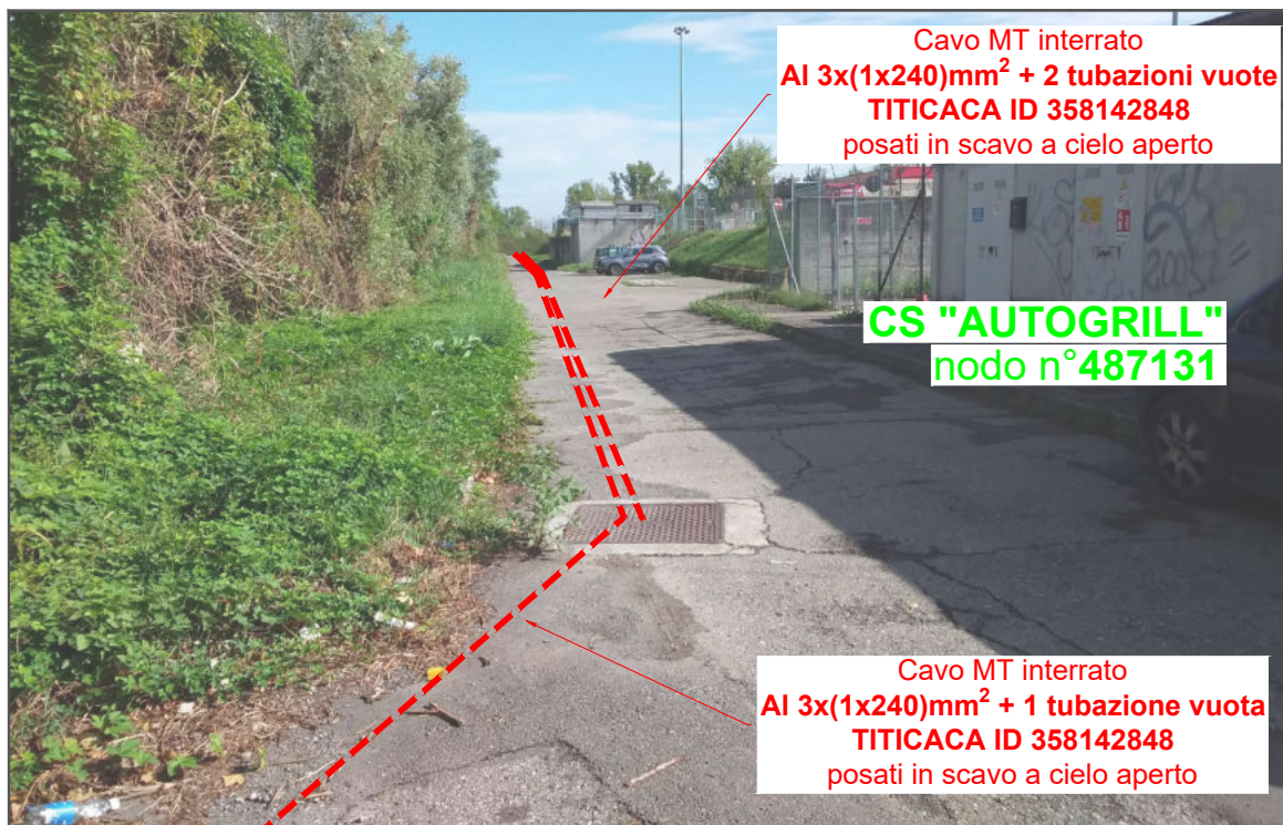
Foto 25: Nuova linea MT in partenza dalla cabina primaria CP COLLECCHIO in arrivo presso CS "AUTOGRILL", nodo n°487131
