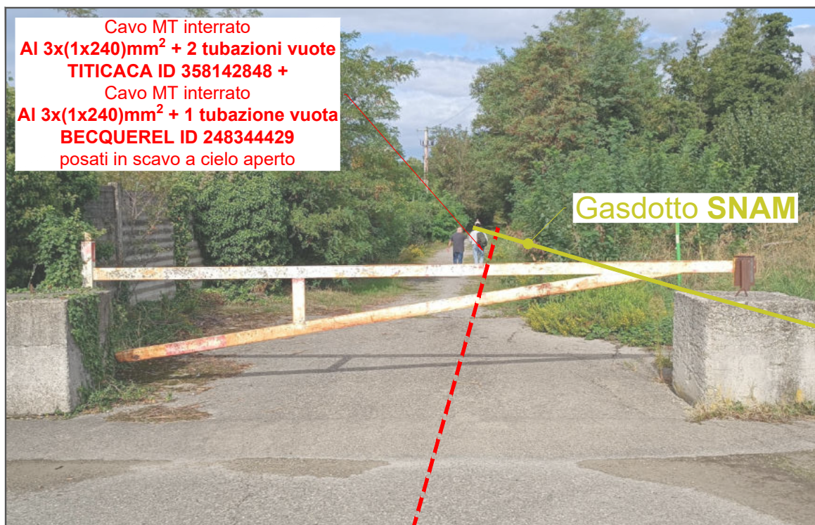
Foto 4: Nuova linea MT in partenza dalla cabina primaria CP COLLECCHIO in percorrenza lungo via Scodoncello e in attraversamento con Gasdotto SNAM
