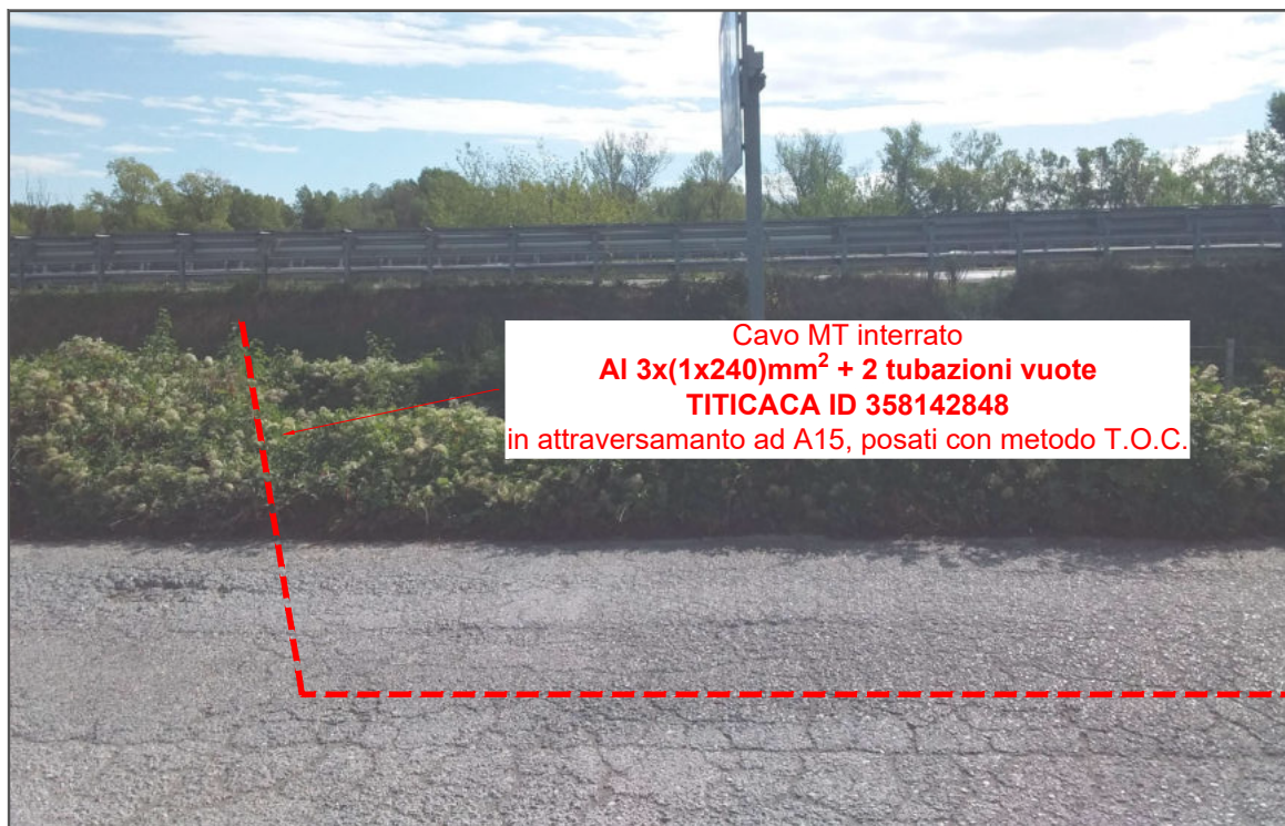
Foto 24: Nuova linea MT: attraversamento A15 Autostrada della Cisa, realizzato mediante T.O.C. e parallelismo realizzato con posa mediante scavo a cielo aperto su strada di accesso all'autogrill
