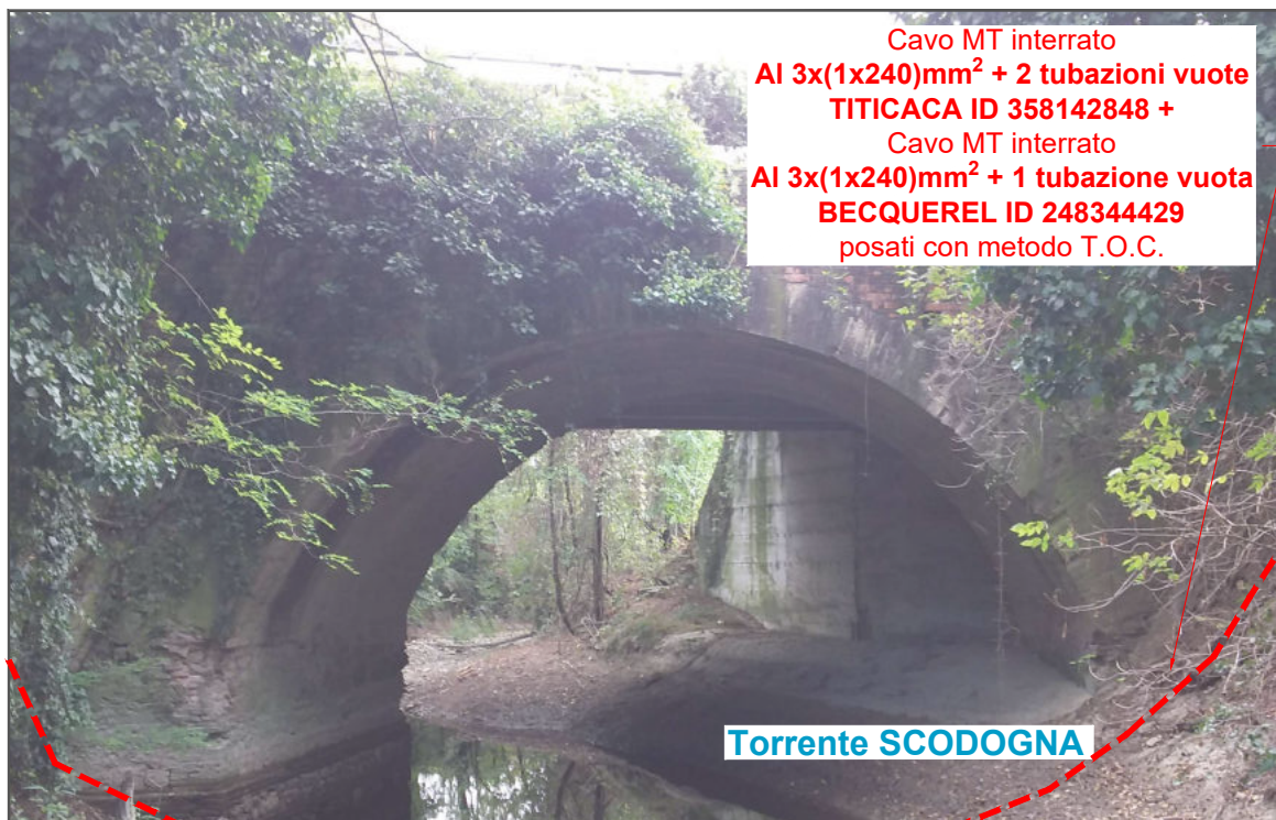
Foto 1: Nuova linea MT in partenza dalla cabina primaria CP COLLECCHIO in percorrenza lungo via Scodoncello e attraversamento Torrente Scodogna
