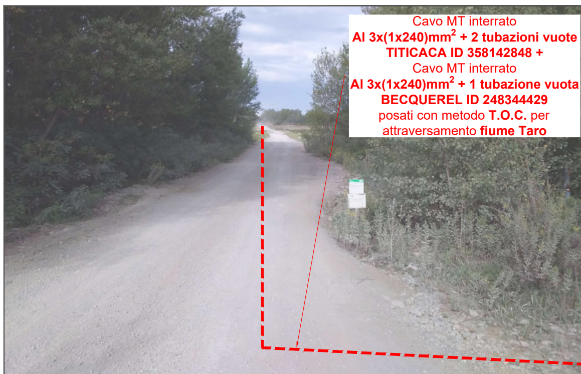
Foto 9: Nuova linea MT in partenza dalla cabina primaria CP COLLECCHIO in percorrenza lungo strada sterrata in proprietà privata in proseguimento di via Scodoncello e conseguente lancio TOC per attraversamento Fiume Taro
