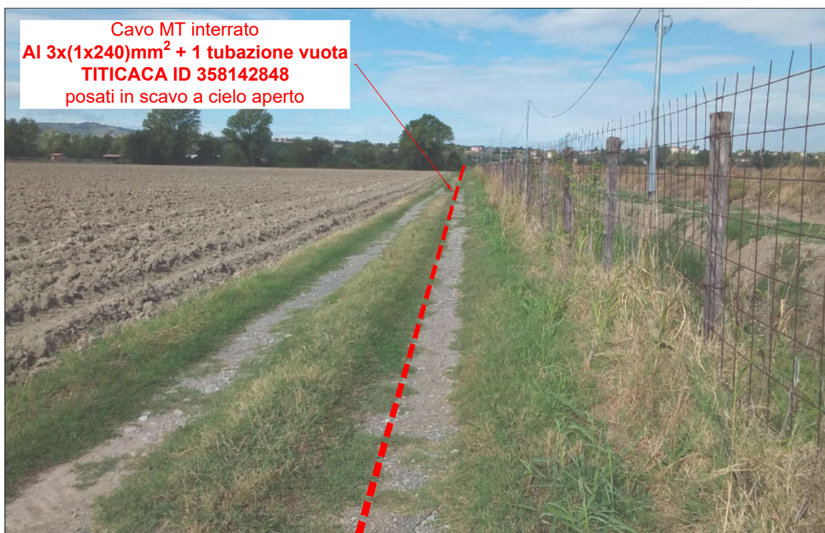
Foto 27: Nuova linea MT in partenza dalla cabina primaria CP COLLECCHIO in parallelismo di canale esistente.
