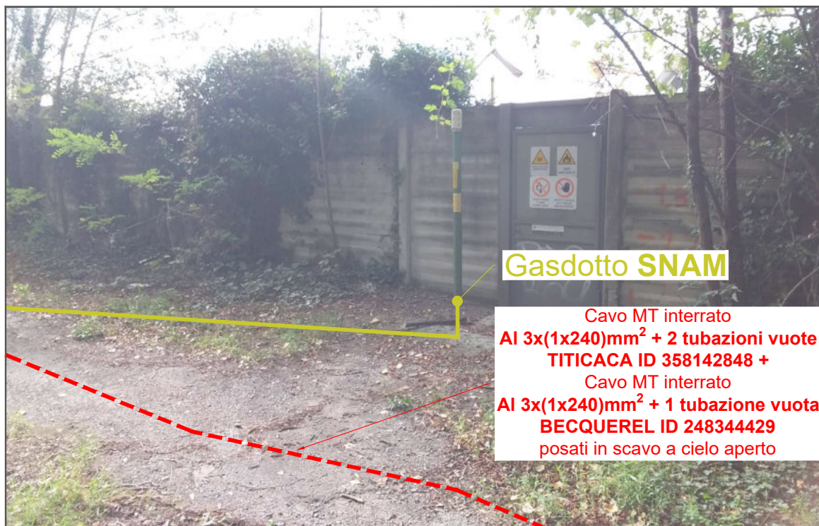
Foto 7: Nuova linea MT in partenza dalla cabina primaria CP COLLECCHIO in percorrenza lungo strada sterrata in proprietà privata in proseguimento di via Scodoncello e in attraversamento con Gasodotto SNAM
