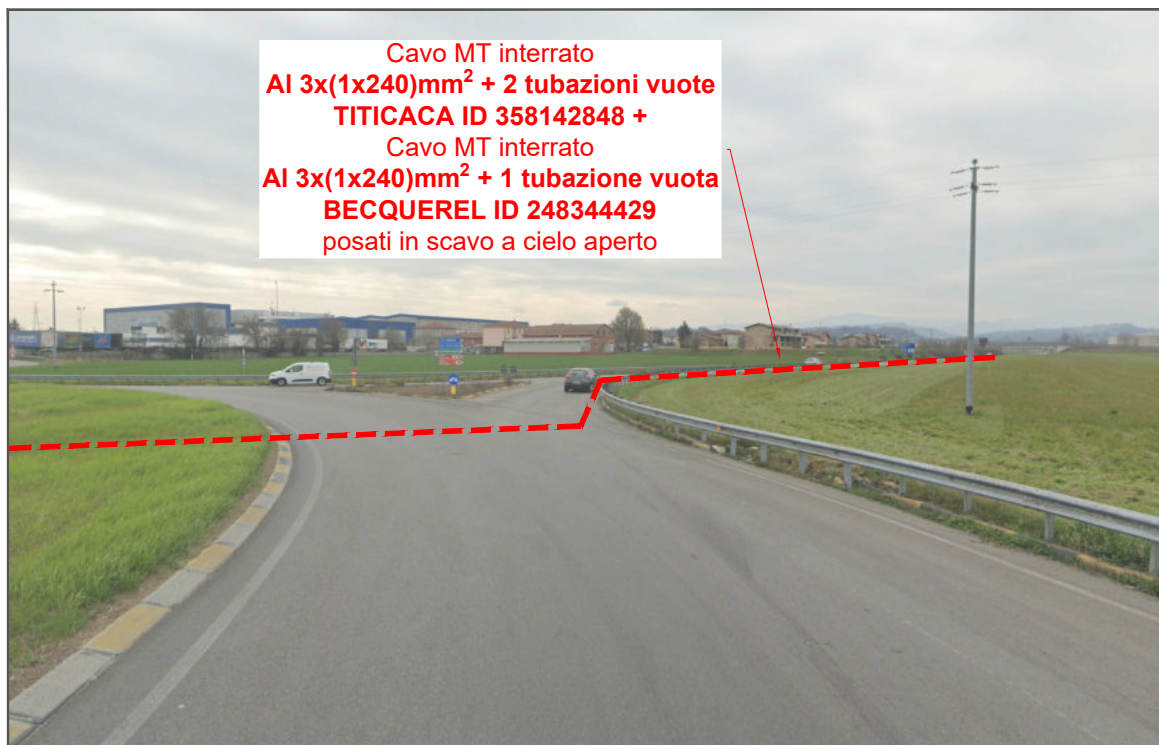
Foto 7: Nuova linea MT in partenza dalla cabina primaria CP COLLECCHIO in attraversamento della Strada Statale 62
