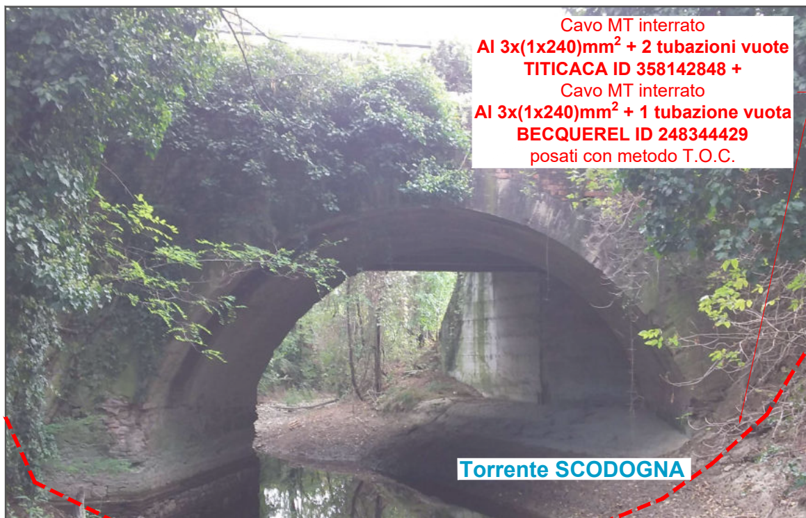
Foto 13: Nuova linea MT in partenza dalla cabina primaria CP COLLECCHIO in percorrenza lungo via Scodoncello e attraversamento Torrente Scodogna
