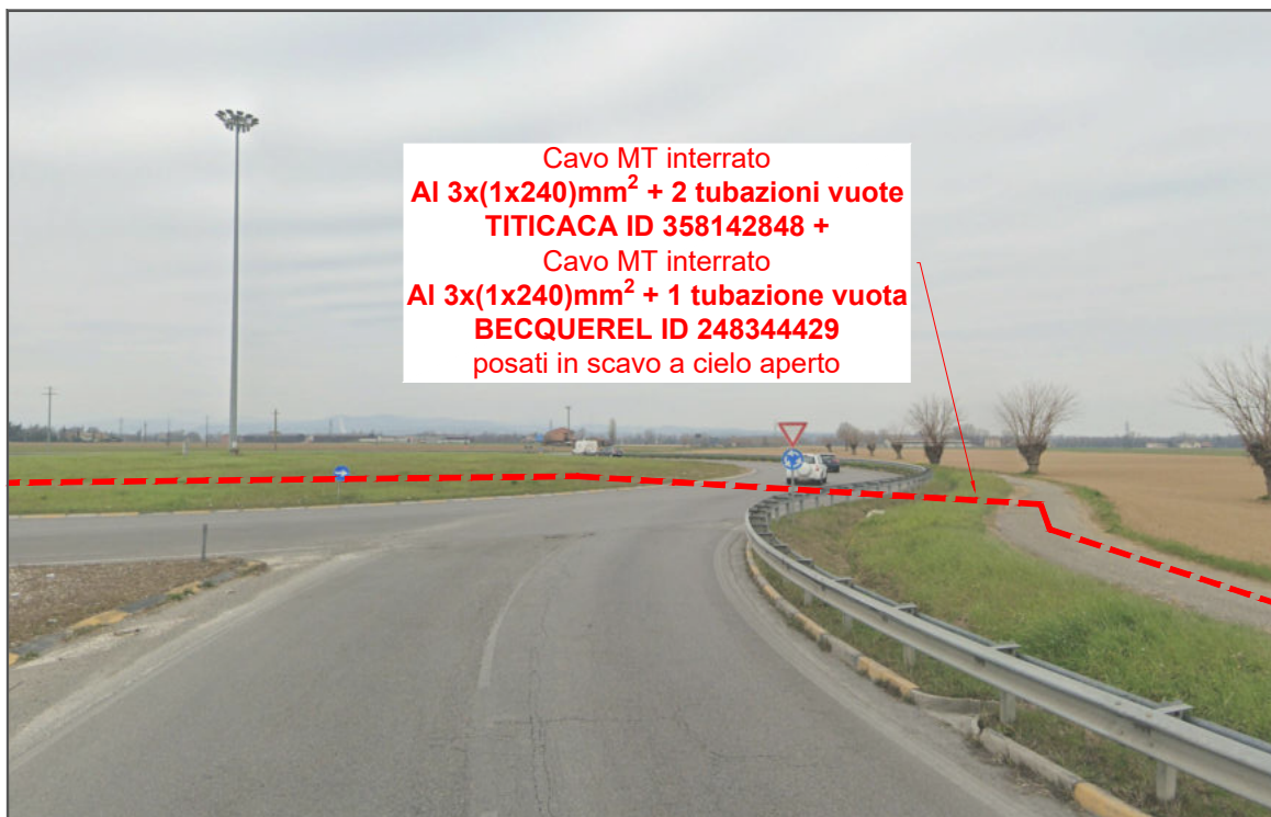
Foto 1: Nuova linea MT in partenza dalla cabina primaria CP COLLECCHIO in transito lungo la pista ciclabile parallela alla SS 62, in attraversamento della Strada Statale 62
