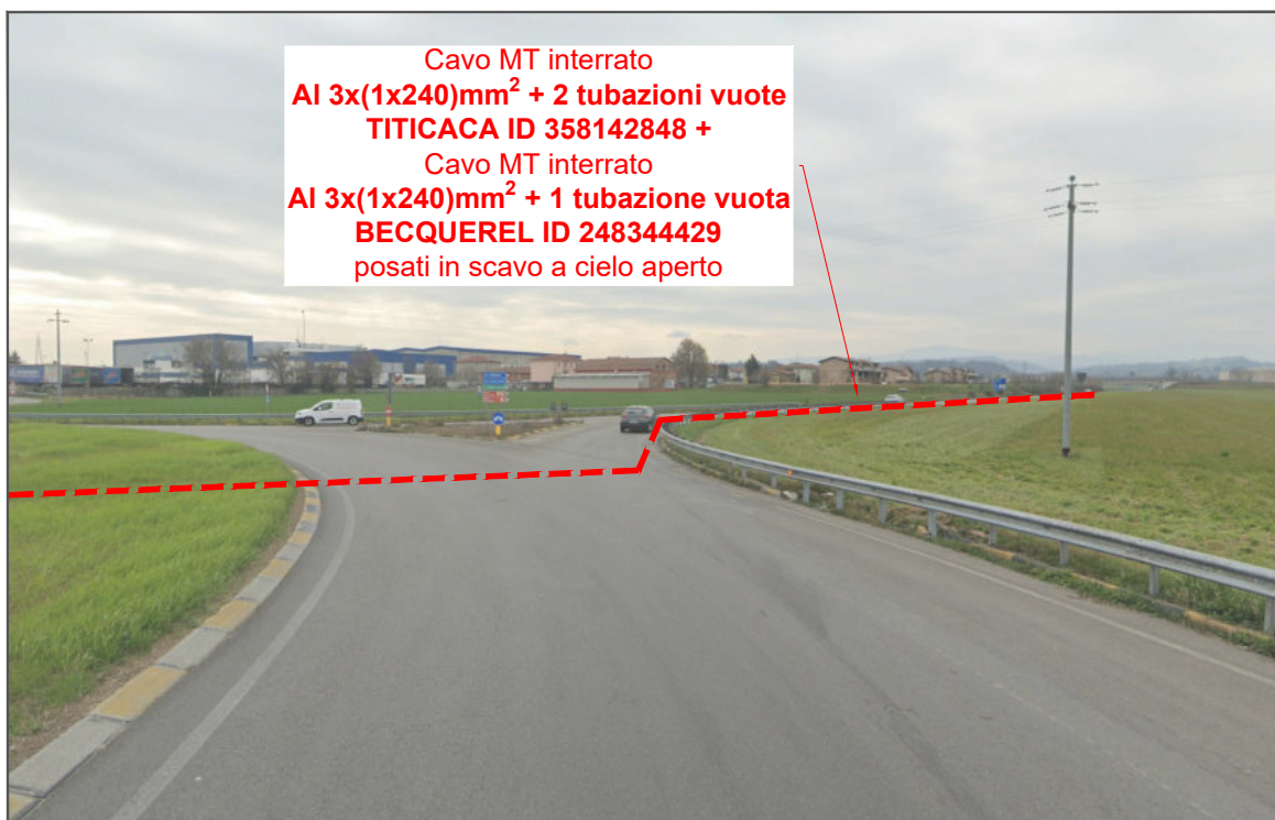
Foto 2: Nuova linea MT in partenza dalla cabina primaria CP COLLECCHIO in attraversamento della Strada Statale 62
