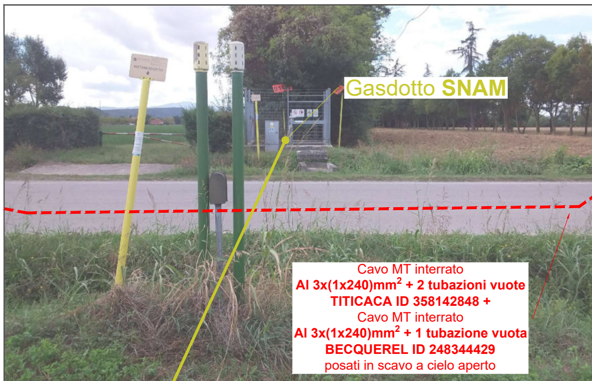
Foto 11: Nuova linea MT in partenza dalla cabina primaria CP COLLECCHIO in percorrenza lungo via Scodoncello e interferenza con Gasdotto SNAM
