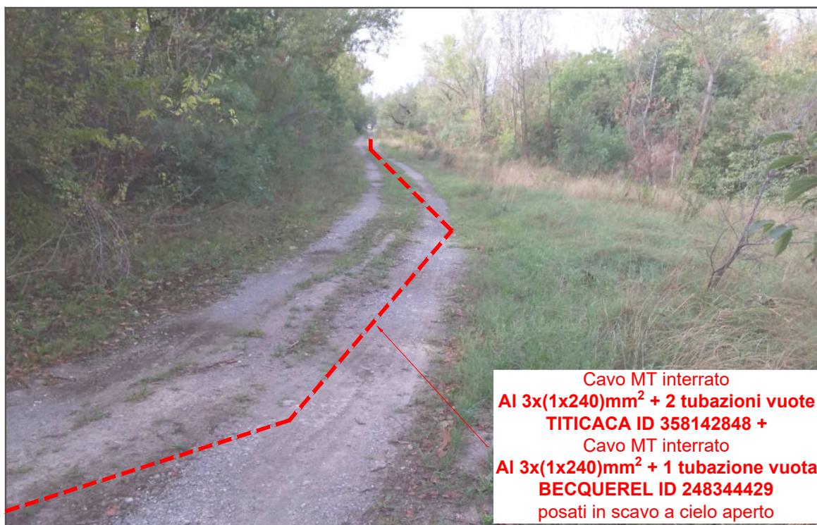
Foto 20: Nuova linea MT in partenza dalla cabina primaria CP COLLECCHIO in percorrenza lungo strada sterrata in proprietà privata in proseguimento di via Scodoncello
