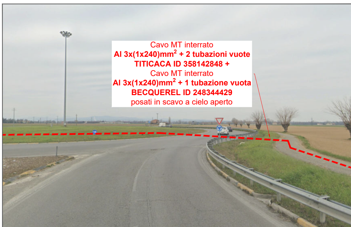
Foto 6: Nuova linea MT in partenza dalla cabina primaria CP COLLECCHIO in transito lungo la pista ciclabile parallela alla SS 62, in attraversamento della Strada Statale 62
